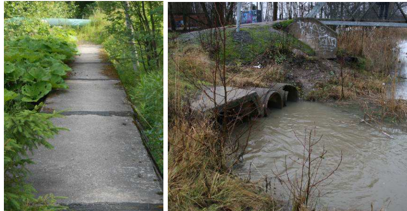
Fortumin vanhin kaukolämpölinjan betonikansi näkyy maastossa- ja toimii epävirallisena ulkoilureittinä. Oikeanpuoleisessa kuvassa Finnobäckenin eteläpuolen rantatörmässä Djup-sundbäckenin purkureittejä. Kuvat J.S. ja E.B.
