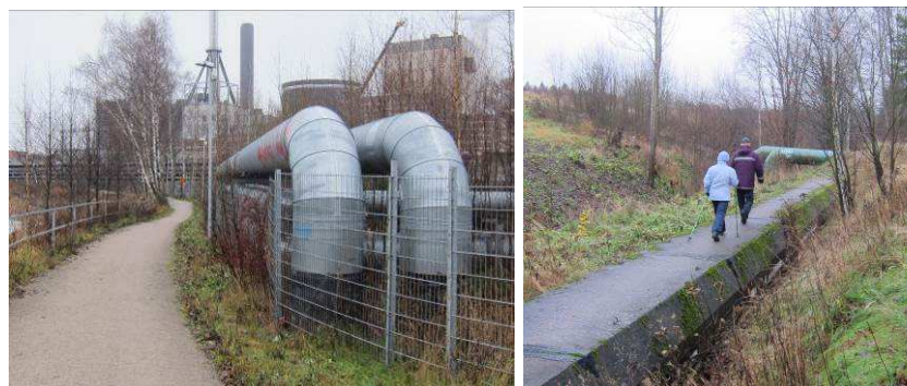
Putket ja johdot tuovat oman lisänsä virkistysmaisemaan. kuvat T.T.
