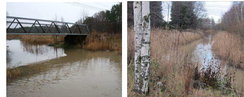
Vasemmalla Finnobäcken laskee pian kevyen liikenteen sillan jälkeen etelässä mereen. Kuvat on otettu syksyn tulvien aikaan. Oikealla Finnobäckenin uoma altaan pohjoispuolella alkuperäisellä paikallaan. Kuvat E.B. ja T.T.
