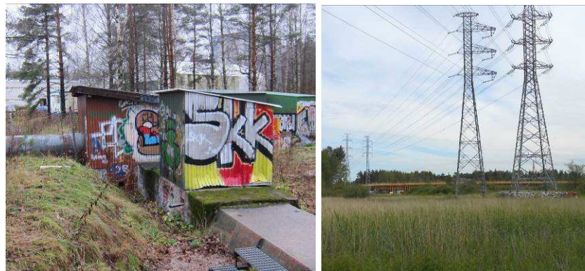
Vasemmassa kuvassa altaan lounaiskulman kaukolämpöön liittyviä rakenteita, oikealla alueen poikki linjattu 110 kV:n sähkönsiirtolinja. kuva T.T. ja J.S.
