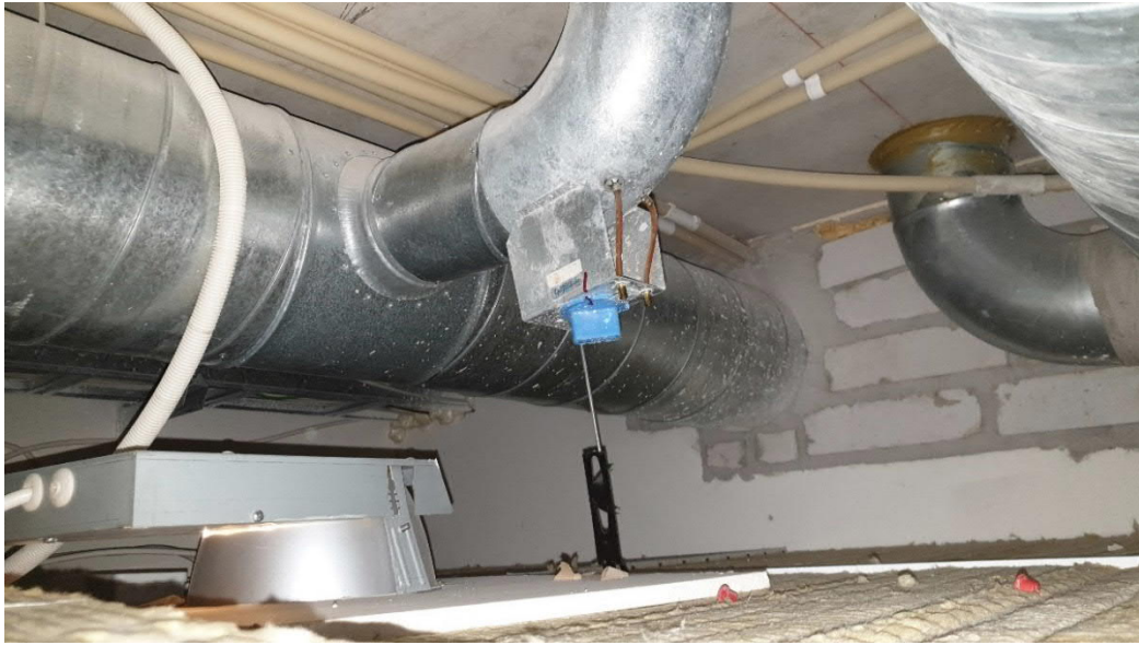
Kuva 2. Alaslasketun katon yläpuolella läpiviennit on tiivistetty, tila 208.
