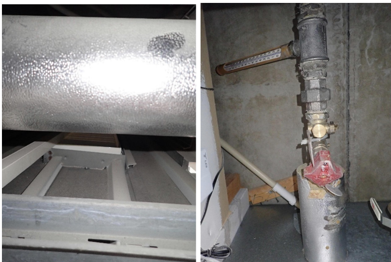
Kuva 1. Yläpohjaa ja alas laskettua kattoä tarkastettiin tuulikaapissa 226. Pinnat olivat siistit eikä poikkeavia hajuja havaittu.
