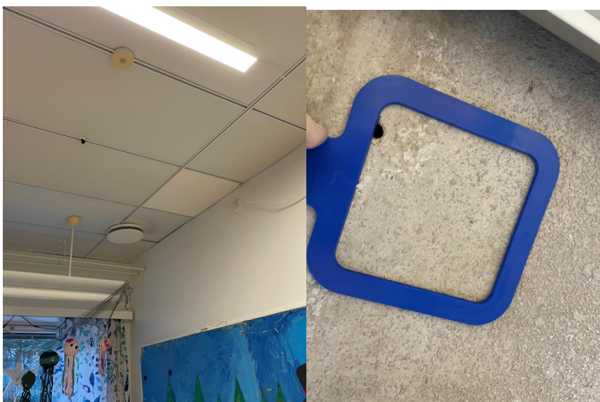
Kuvat 5-6. Ryhmätilassa 233 oli akustilevy vaihdettu aiemmin vesivuotokohdalta. Akustilevyissä tai ontelolaatan alapinnalla ei havaittu kosteusjälkiä. Ontelolaatan alapinnalla ei havaittu kosteutta. Pintasivelynäytteessä ei havaittu poikkeavaa mikrobikasvustoa (näyte MP5).
