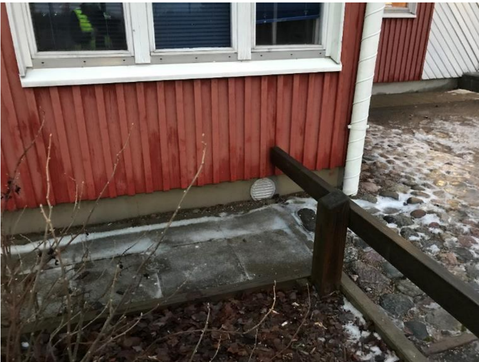
Kuva 5.8. Alapohjan tuuletussäleiköt ovat maan rajassa.
