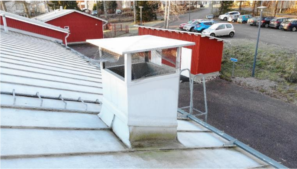
Kuva 5.7. Poistopiipun verkko on rikki.
