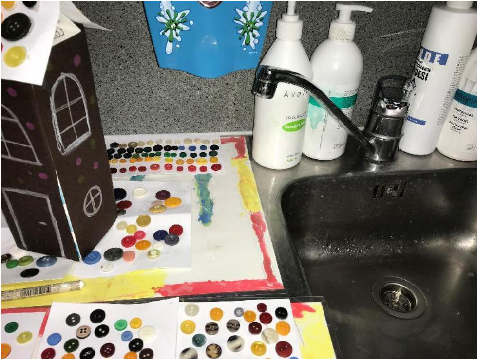
Kuva 5.5. Useiden hanojen sivuliikerajoittimet puuttuvat ja vesi pääsee pöydille.
