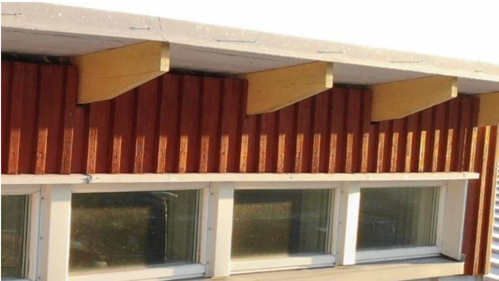
Kuva 4.1. Vesikaton reunapellin kiinnitysnaulat.
