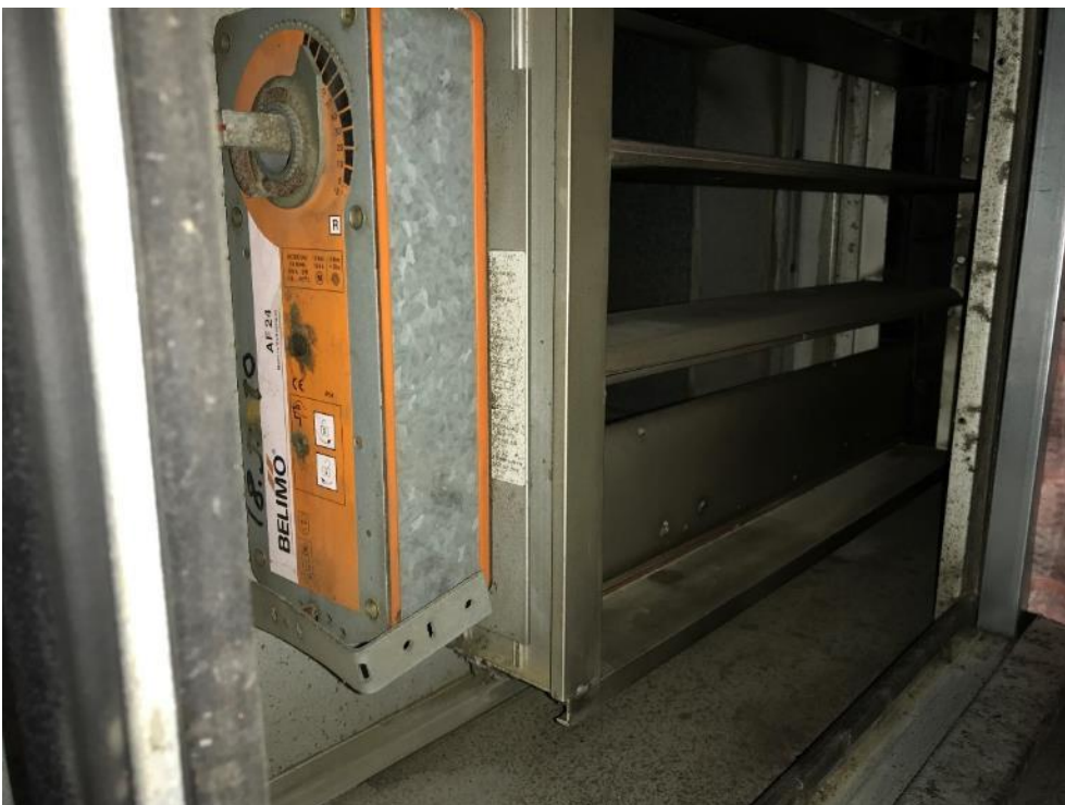
Kuva 5.2. Raitisilmapellin alimmainen säle ei käänny.
