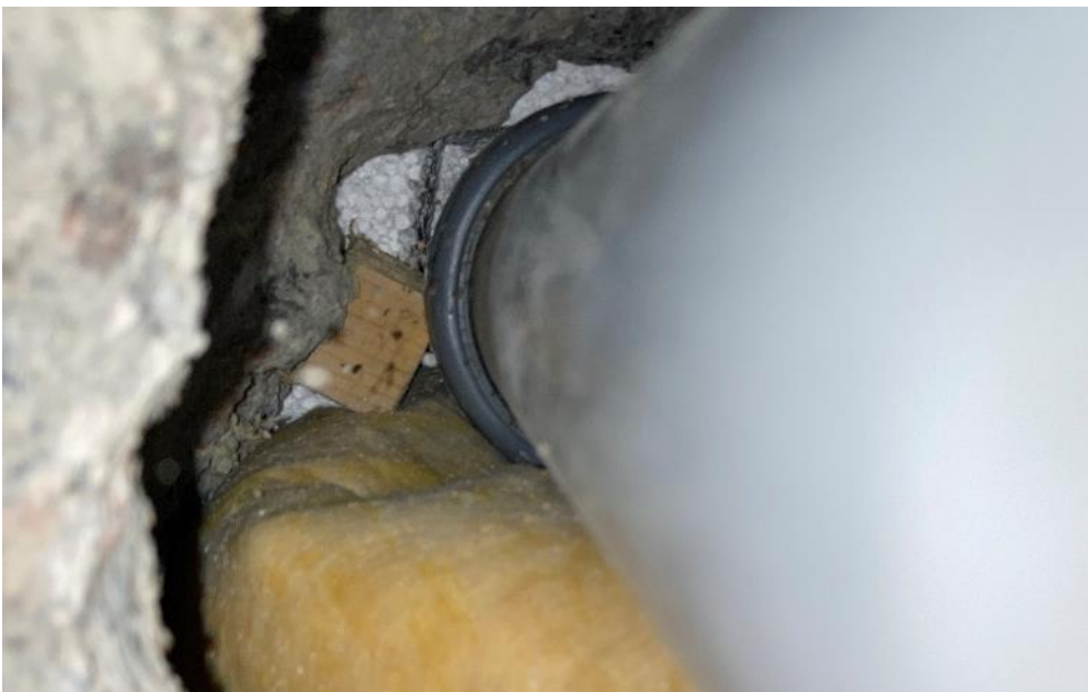
Kuva 4.7. Alapohjan läpivienti.
