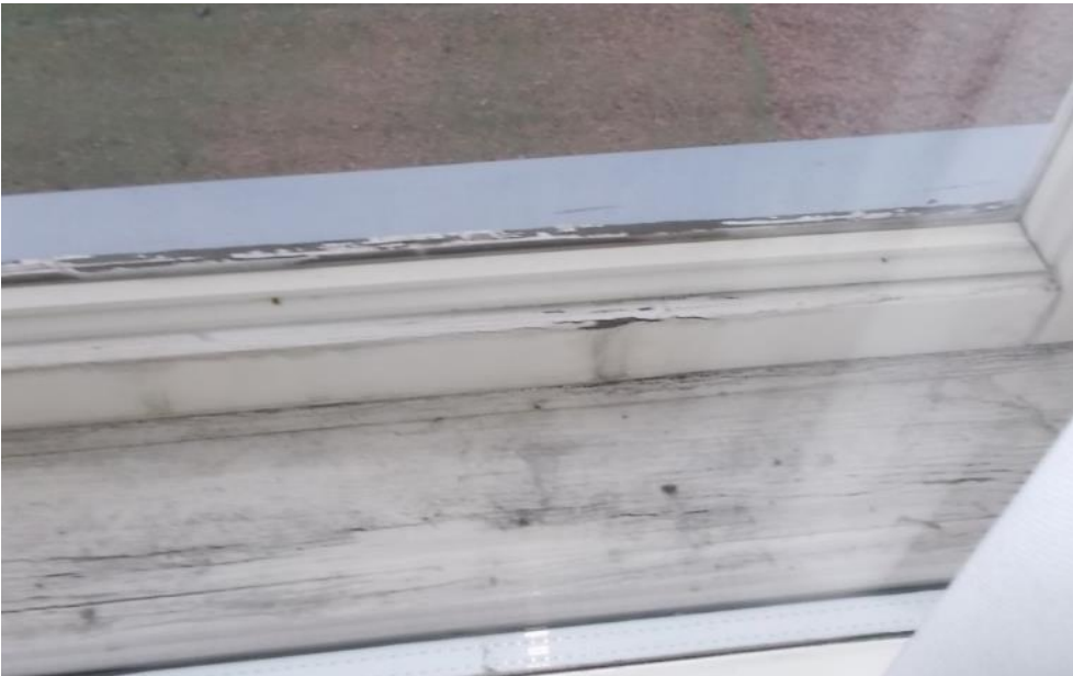
Kuva 4.5. Ikkunan puitteet Leikkutilassa 127.
