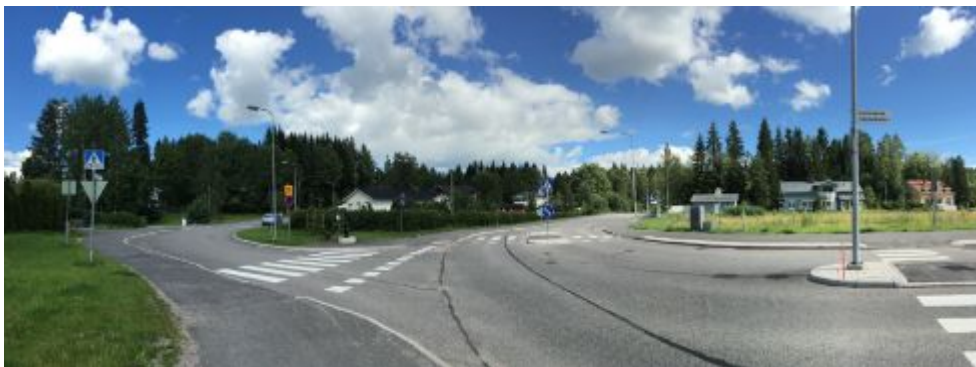
Voimakkaasti muuttunutta historiallisen tien lähimaisemaa: kevyen liikenteen väylät, liikenteen ohjaus, valaistus, liikennemerkit, tien leveys ja vesien ohjaus, ympäröivä rakentaminen ja pinnoitteet luovat modernia tien asua. Huhtamäentie eli vanha yhteys Klaukkalaan kaartaa vasemmalle pohjoiseen. (Sini Moilanen / Espoon kaupunki)
