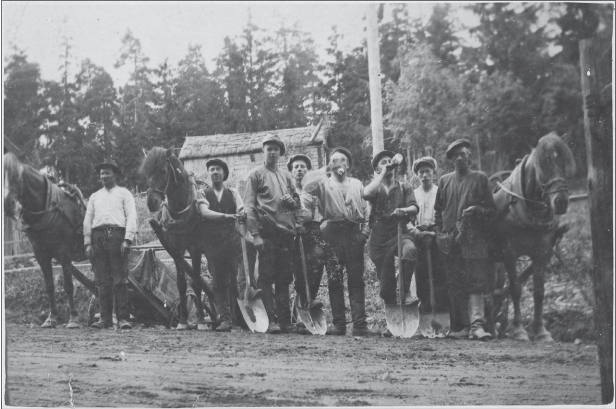
Tauko kunnan järjestämällä tietyömaalla Kauklahdessa. (1920-1939) (Espoon kaupunginmuseo / Esbo Hembyggsförening)
