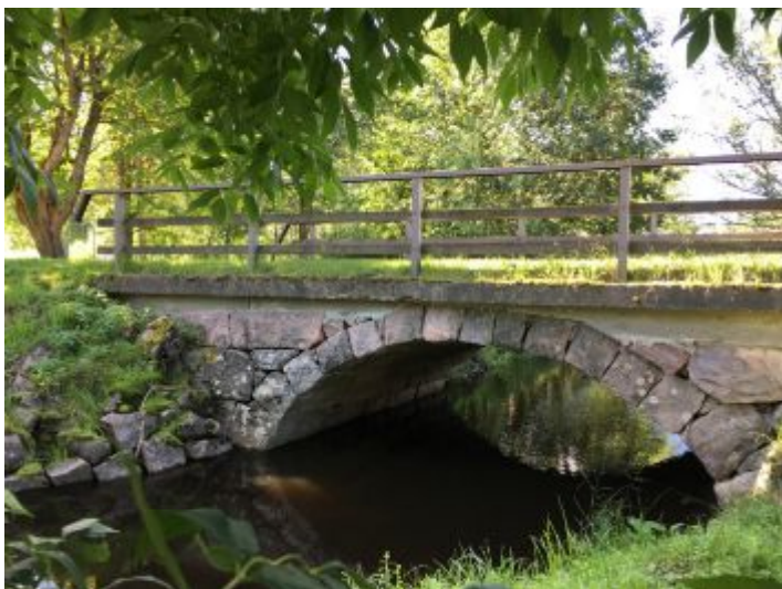
Kiviholvisilta ylittää Gumbölenjoen Engelin puistotiellä. (Sini Moilanen / Espoon kaupunki)
