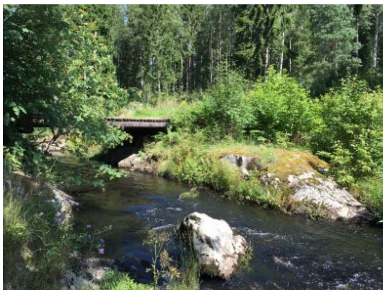
Joskus ylitykset ovat olleet helposti ratkaistavissa. Kallioille perustettu puukantinen silta ylittää Mustanpuron. (Sini Moilanen / Espoon kaupunki)
