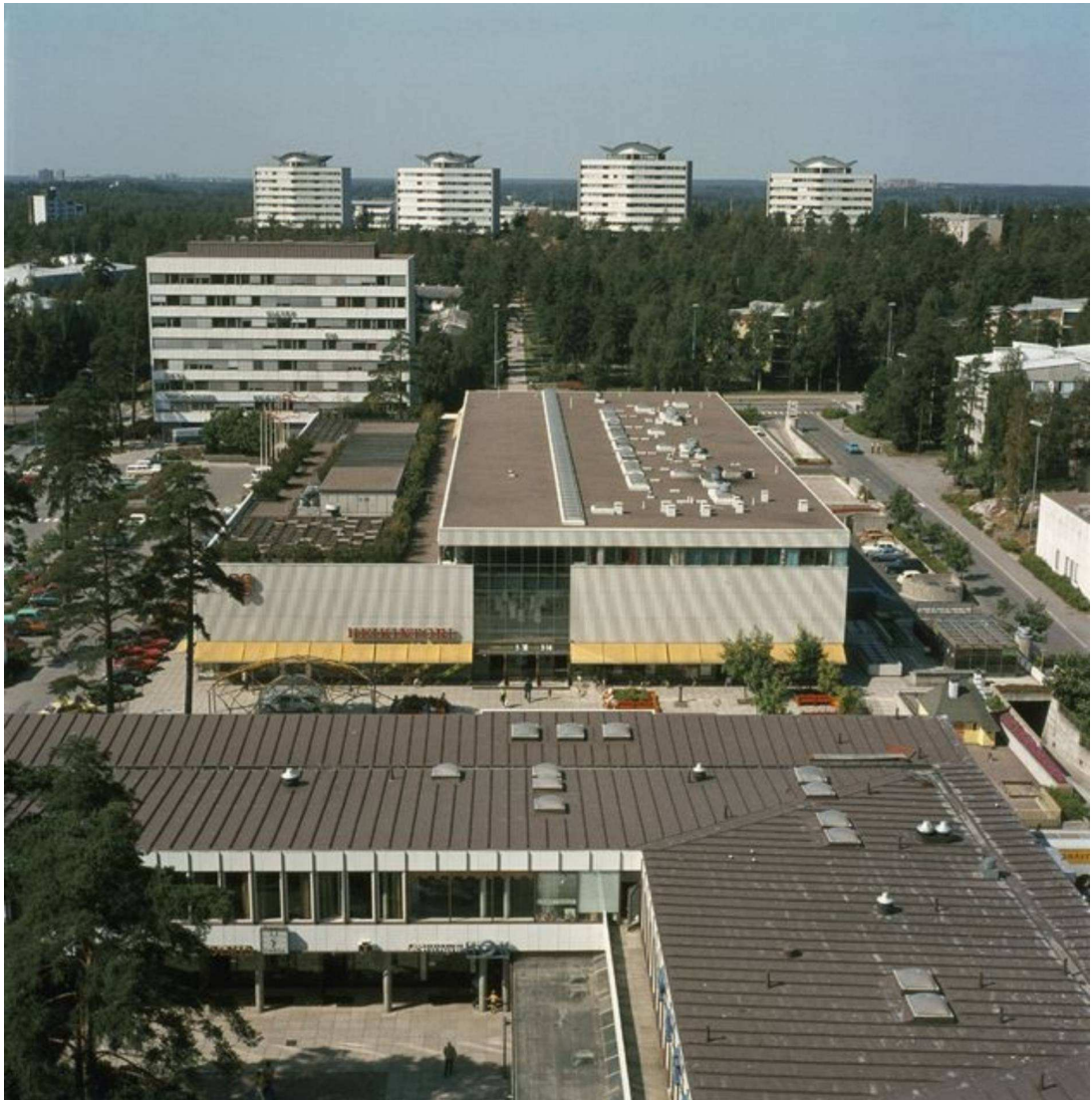
Heikintorin ostoskeskus ja Raitinlukon toimistorakennus eli Konttoritorni II Tapiolatorin suunnasta, idästä länteen katsottuna. Raitinlukon rakennus sijaitsee Tapiolan liikekeskustan länsireunalla. Kuva: Volker von Bonin, ei vuosilukua. Finna-kuvapalvelu, Museoviraston kuvakokoelma.
