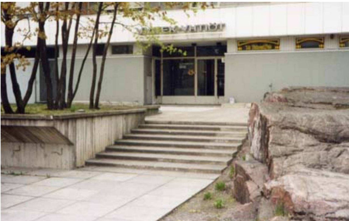
Pihaa pääsisäänkäynnin edustalla: portaat, tukimuuria ja kallioleikkausta, nykytilanne
