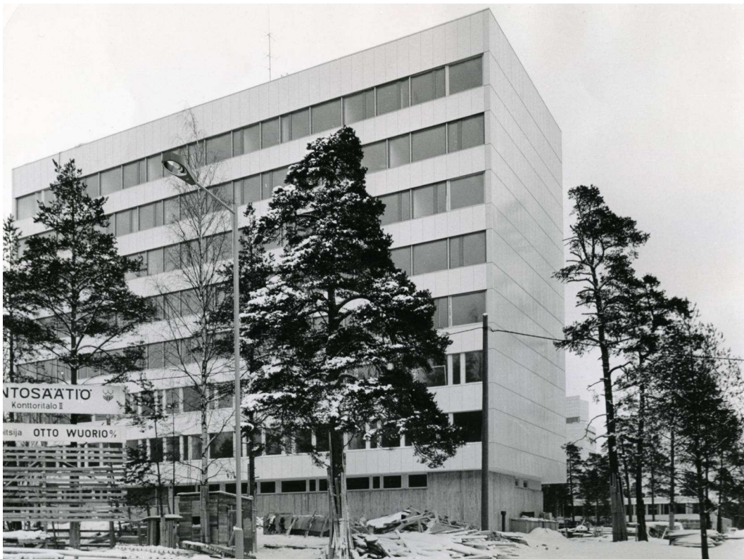
Julkisivua länteen Pohjantielle, rakennustyömaa käynnissä vuosi 1966. Toteutunut pohjakerrosratkaisu on julkisivuiltaan umpinainen sekä länteen että itään. Pohjakerroksen nauhaikkunat eivät kierrä jatkuvina koko rakennuksen ympäri. Kuva: Asuntosäätiön kuvakokoelma, Espoon kaupunginmuseo
