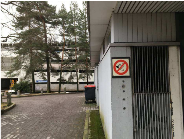
Jätehuone sijaitsee sisäänkäyntijulkisivulla
