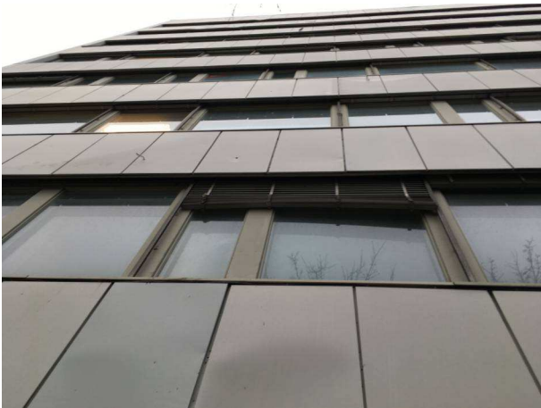
Toimistokerrosten julkisivua, ulkopuoliset sälekaihtimet
