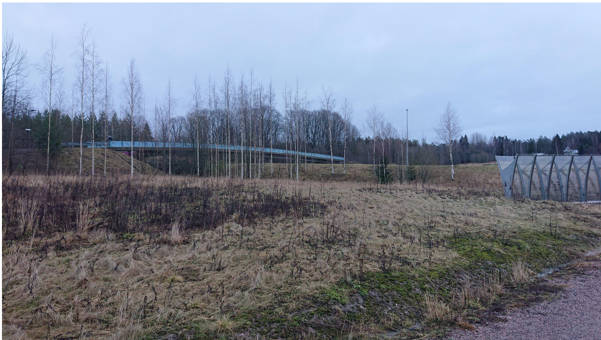
Näkymä Kehä II:sen länsipuolelta. Sillan ympäristö on pääosin rakentamatonta. Kuvan oikeassa reunassa näkyy myös Suurpellon meluseinää.
