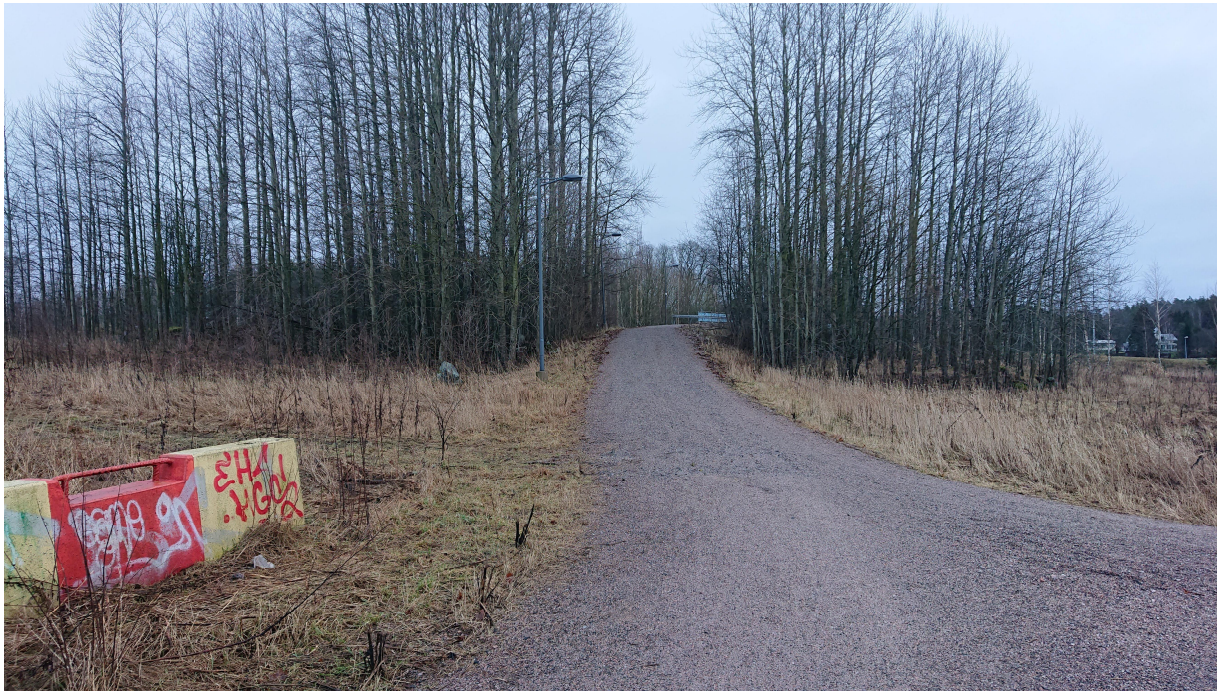
Näkymä sillalle johtavalta länsipuolen kevyen liikenteen väylältä. Silta on rakennettu kahden puustoisien kukkulan välille.
