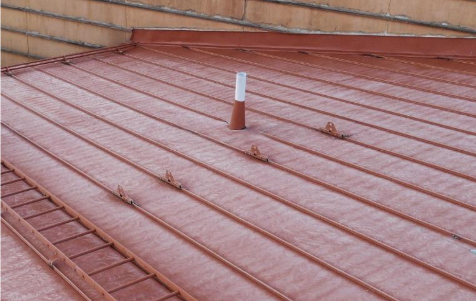
Kuva 4.4. Lumiesteestä puuttuvat putket.
