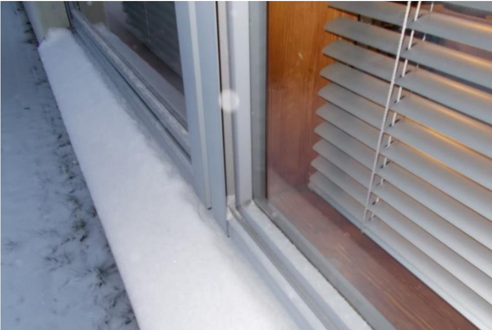
Kuva 4.6. Ikkunan ulkopuite on auki Lepohuoneessa 025.
