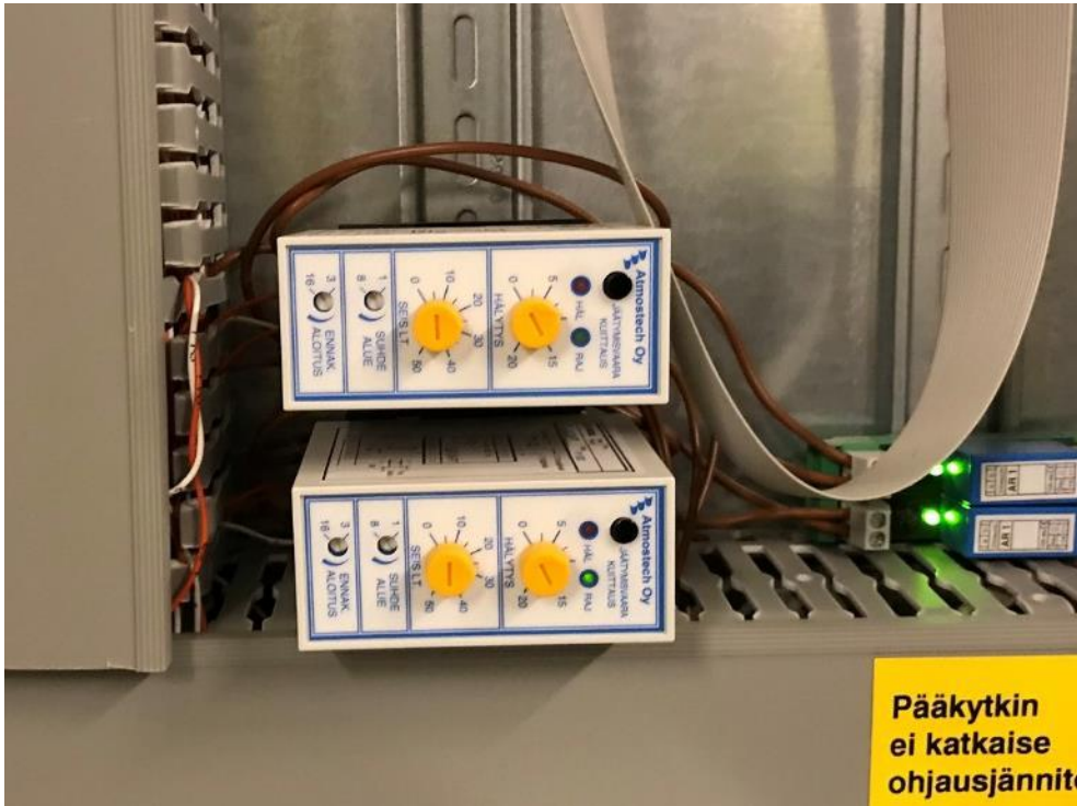
Kuva 6.1. Vialliset jäätymissuojat.
