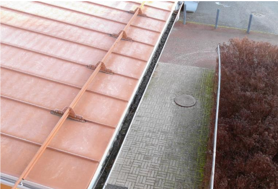
Kuva 4.5. Sadevesikouru on puhdistamatta.
