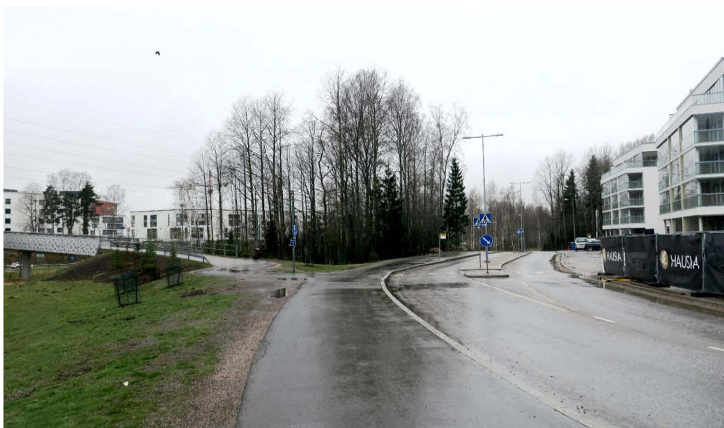
Kuva 8. Hyvin pieni liito-oravan ydinalue Korkoontien varrella. Oikealla näkyvät rakennukset on tehty liito-oravan kulkuyhteyden kohdalle. Kadunvarren nurmelle on istutettu muutamia puita, mutta ne eivät tarjoa vielä vuosiin kulkureittiä liito-oravalle.
