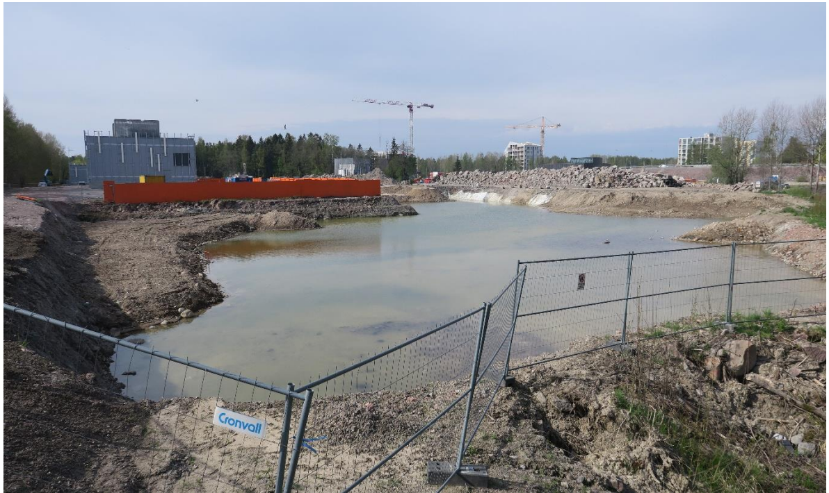
Altaan länsipuolen rakennustyöt ja mittava massanvaihtourakka eivät näyttäneet häiritsevän altaan linnustoa. Kauempana Finnoo-Djupsundsbackenin asemakaava-alueen ensimmäisiä kerrostaloja. Kuva toukokuulta 2021.
