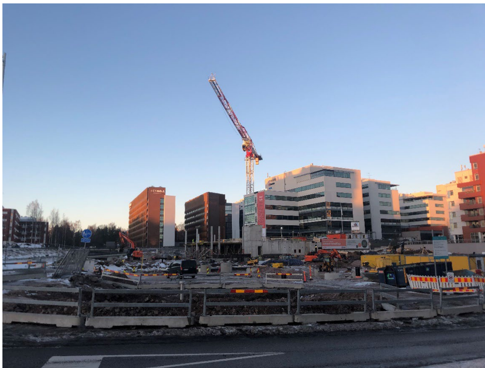
Kuva 2. Alueella rakennetaan Raide-Jokerin päätepysäkkiä. Kuvan suunta etelästä pohjoiseen (kuva: Sitowise Oy, tammikuu 2022).
