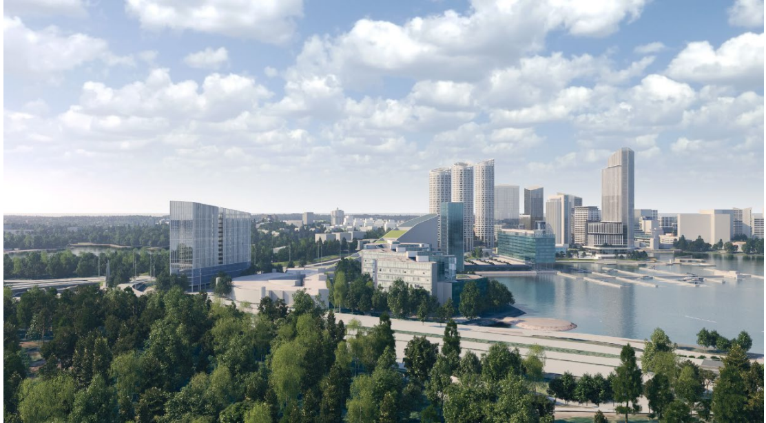
Kuva: Vaihtoehdon 3 rakennus ilmasta Karhusaaresta päin katsottuna.
