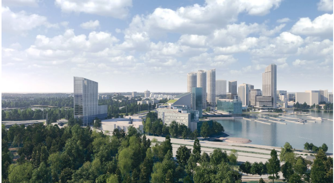
Kuva: Vaihtoehdon 1 rakennus ilmasta Karhusaaresta päin katsottuna.
