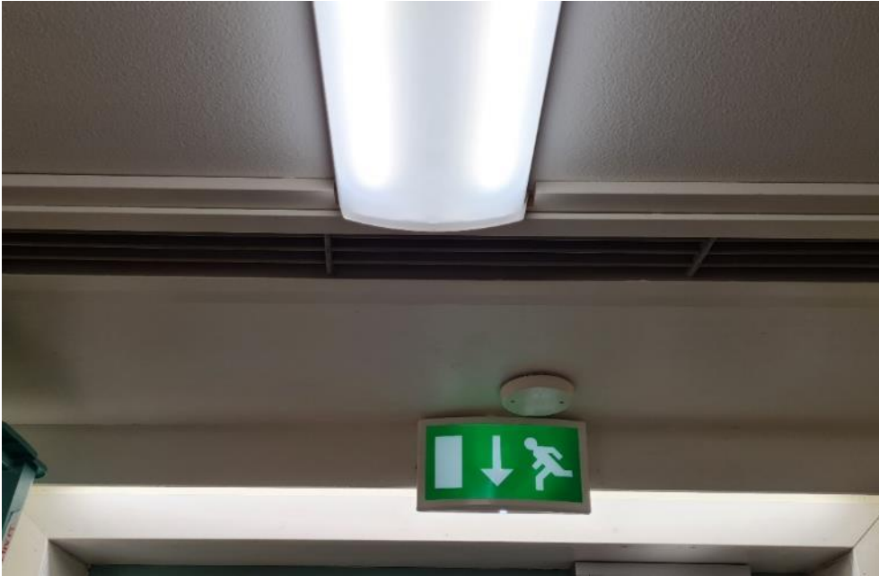
Kuva 6.1. KSK-Puhallin, joka ei käynnistynyt.
