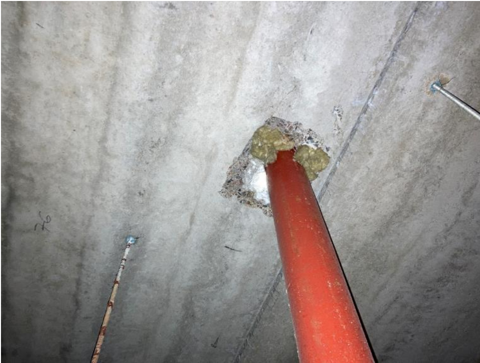
Kuva 4.4. Läpivienti alapohjassa.
