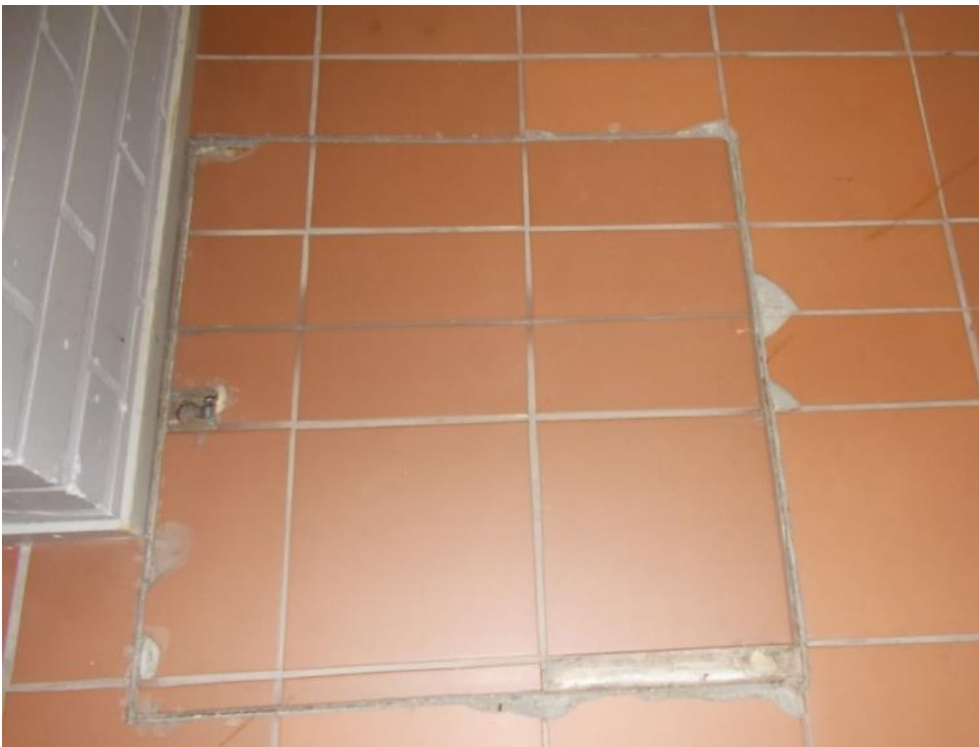
Kuva 4.5. Huoltoluukun laatoitusta Vaatesäilytys D 147.
