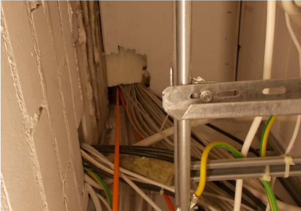
Kuva 4.18. Läpivientejä sähkökeskuksessa.
