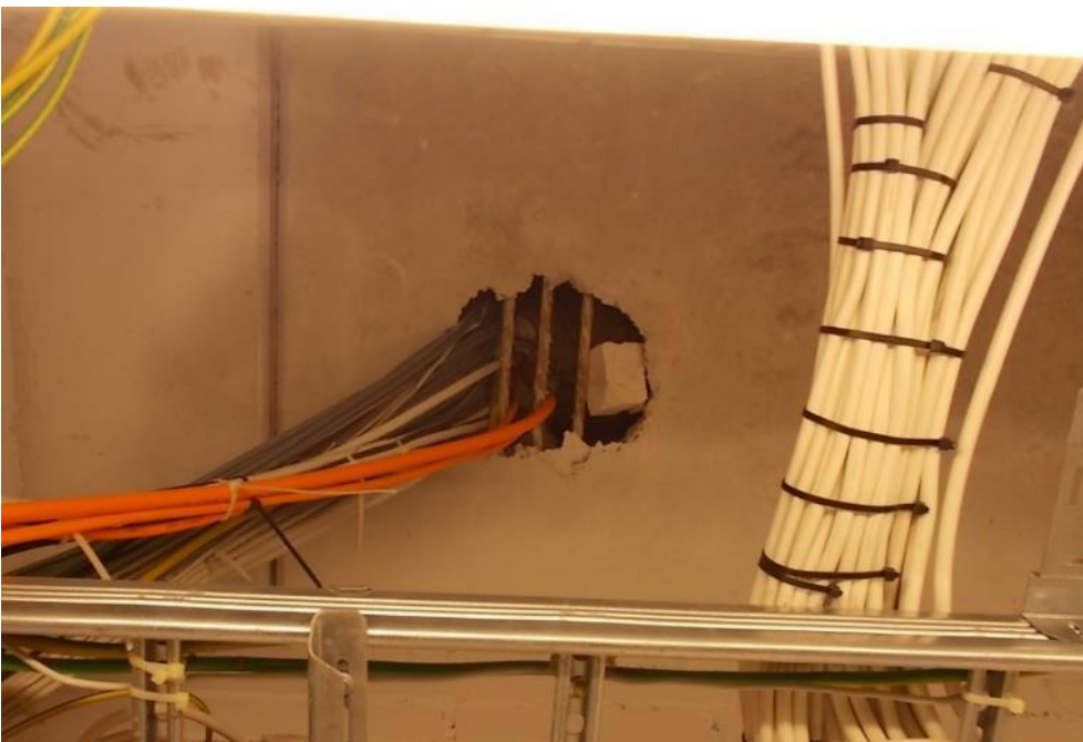
Kuva 4.17. Läpivienti sähkökeskuksessa.
