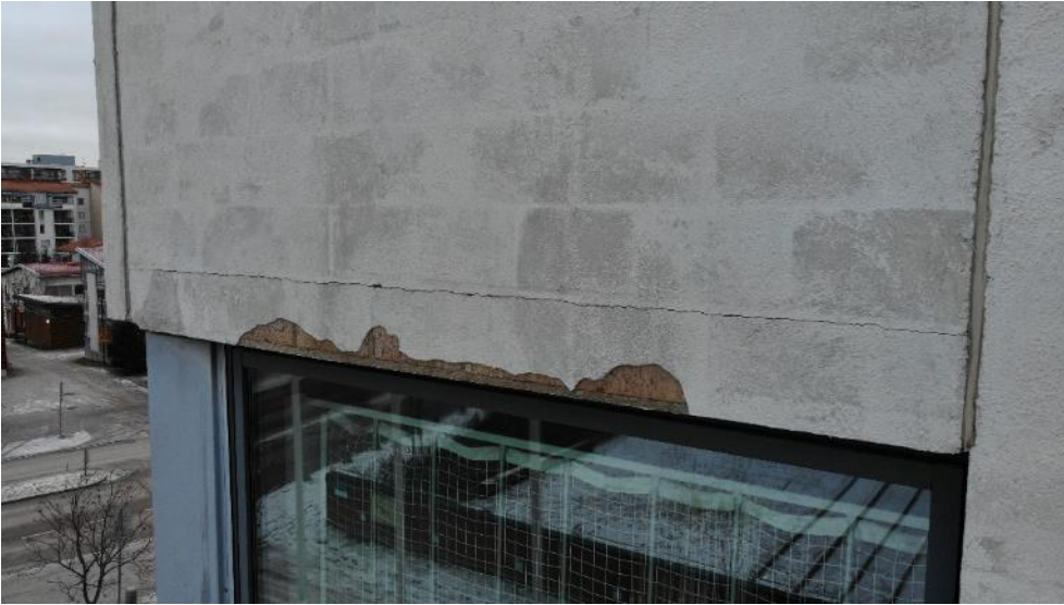
Kuva 4.2. Vaurioita julkisivurappauksessa.
