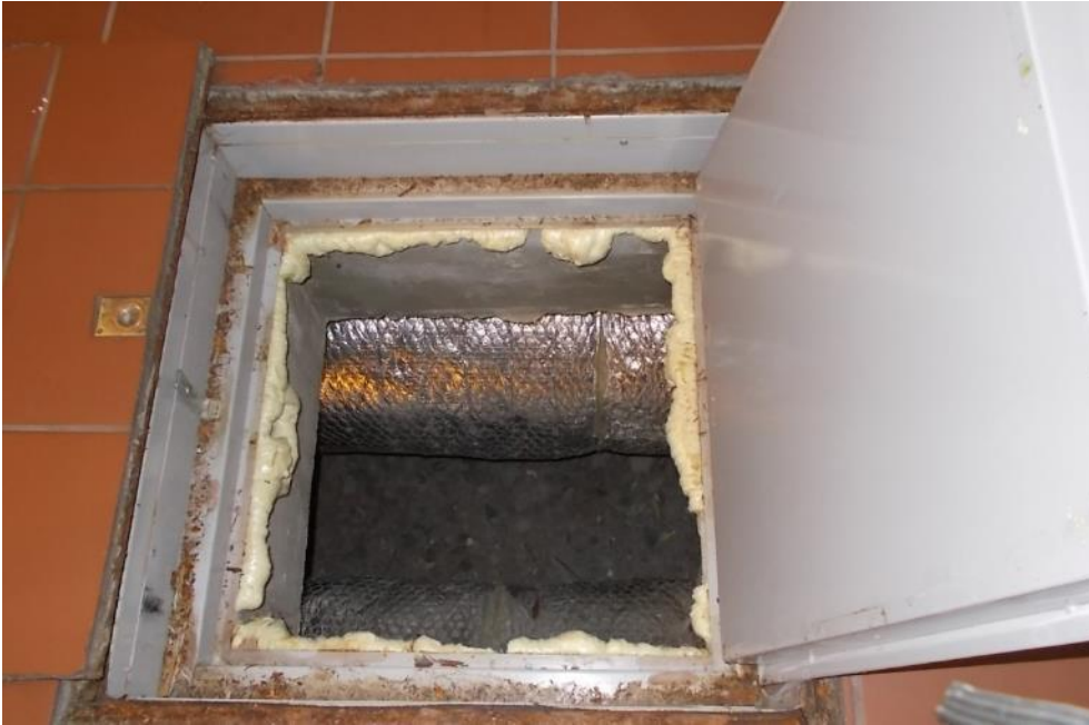
Kuva 4.6. Huoltoluukku alapohjatilaan Ruokailutila D 113.1.
