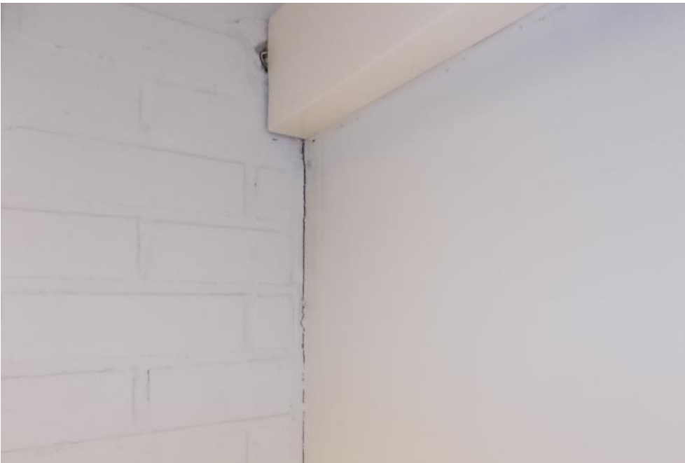
Kuva 4.15. Auennut rakenneliittymä Kuvaamataidon luokassa D 324.
