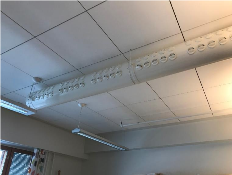
Kuva 5.4. Tuloilman heittokuviot on osin säätämättä.
