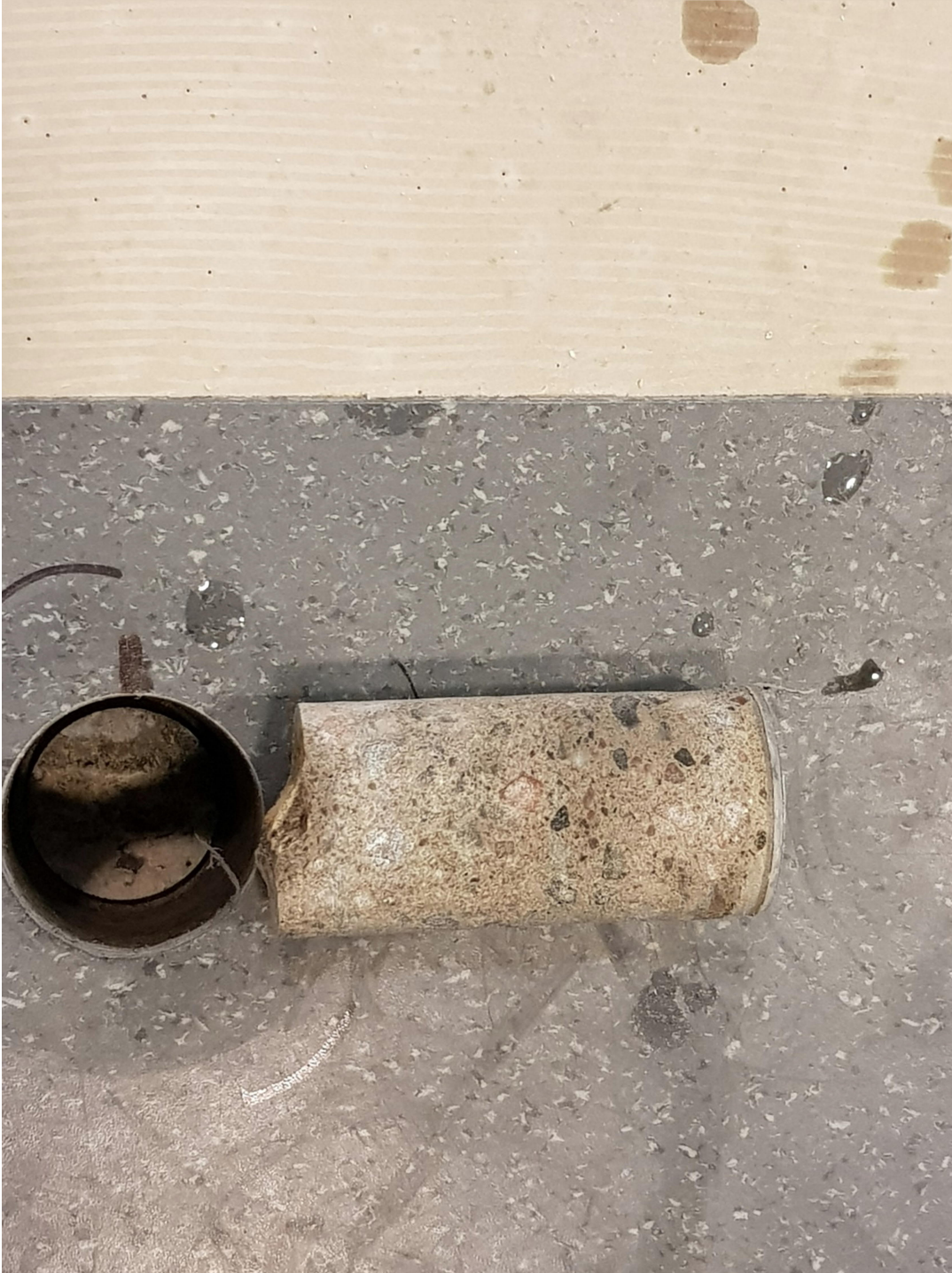
Kuva 2. Näyte VPK1 porattiin muovimaton ja pintabetonilaatan läpi aina kantavan ontelolaatan yläpintaan asti. Kuvan yläosassa näkyvältä alueelta muovimatto on jo irrotettu.
