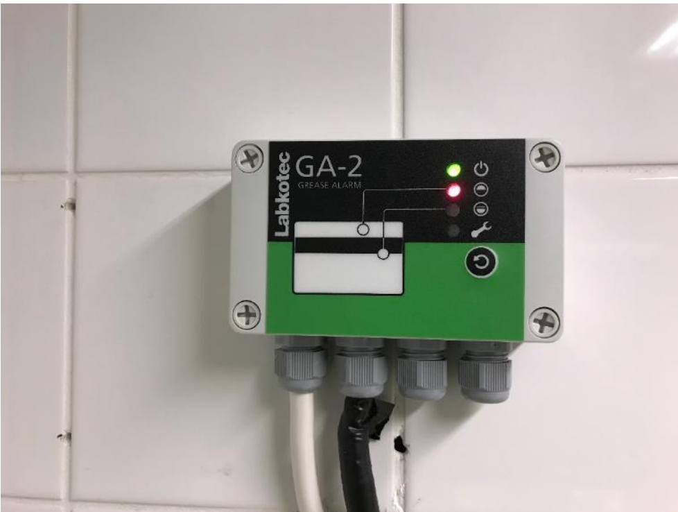
Kuva 5.5. Rasvanerotuskaivossa on padotushälytys päällä.
