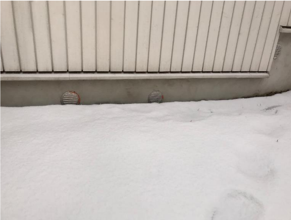
Kuva 5.4. Alapohjan tuuletusritilät ovat maan rajassa.
