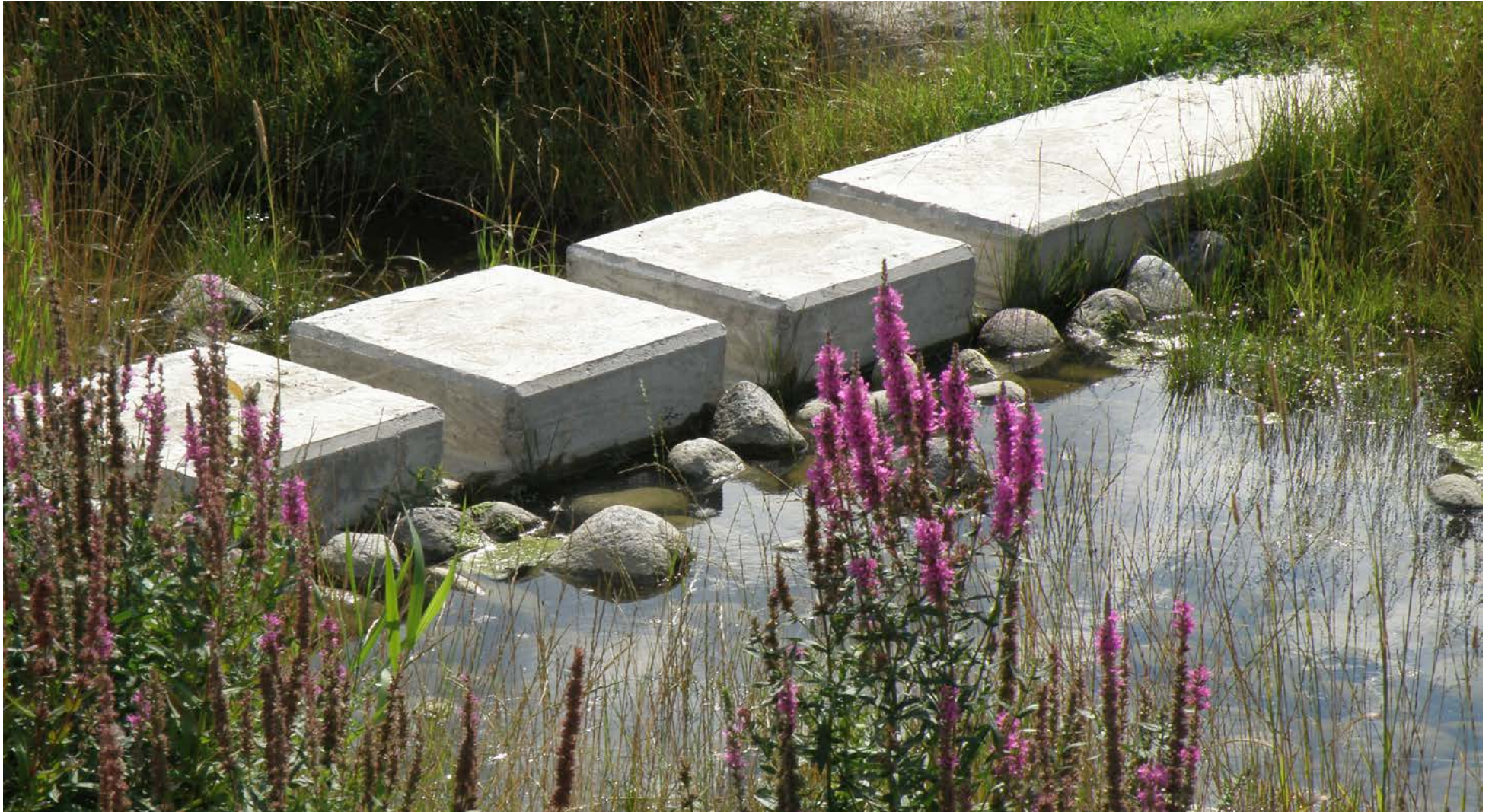
Kuva 3: Hulevesirakenne Järvenpään Lepolassa. Kuva Ramboll.
