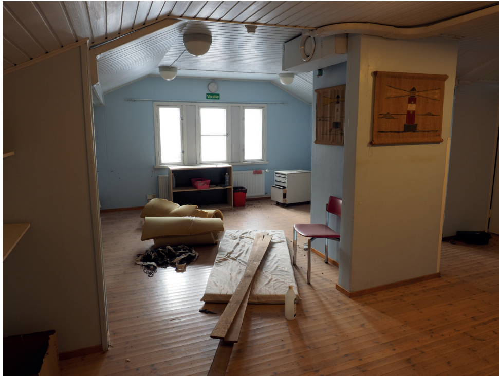
Toisen kerroksen kerhotila. Vuonna 1985 uusittu ikkuna toimii varatienä.
