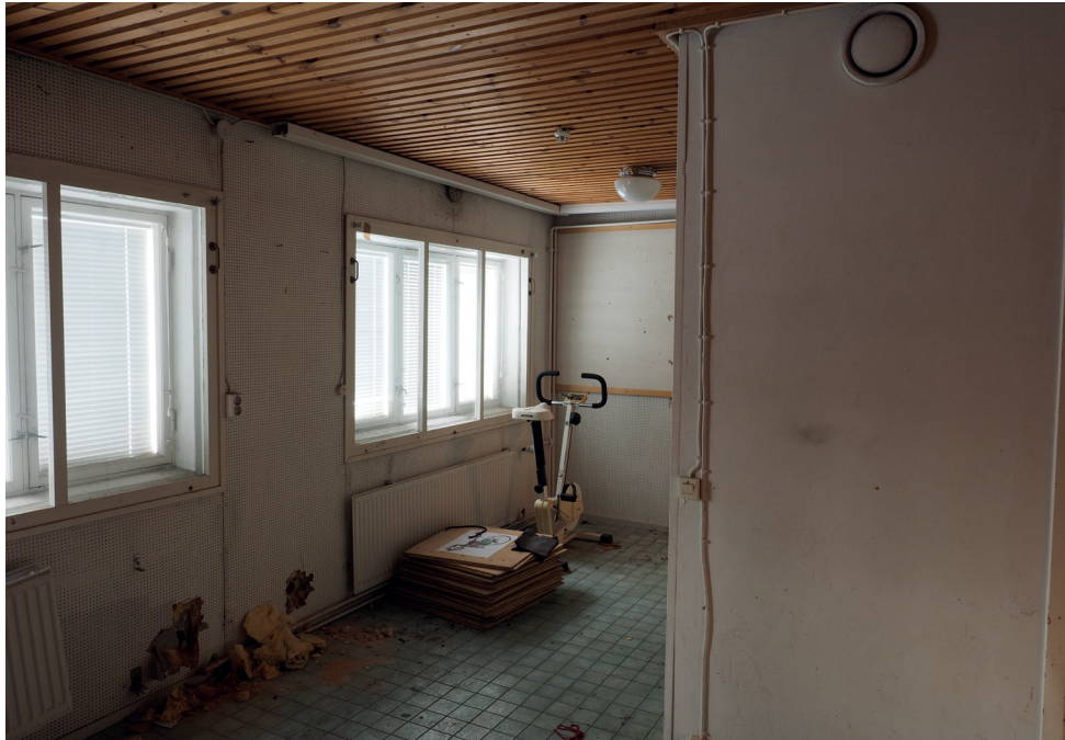
Tämä kellarikerroksen tila on toiminut ainakin asuinhuoneena, partiokolona ja bänditilana.
