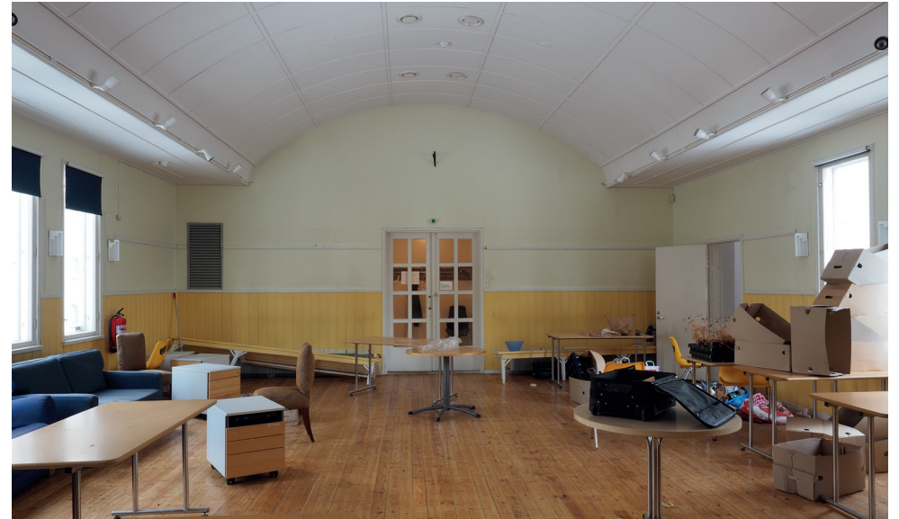
Puolipaneeli, valaisimet ja katon akustinen verhous tehtiin korjauksen yhteydessä. Lattia on alkuperäinen. Alla piirustus takaseinällä näkyvistä, lämpöpattereiden päällä sijainneista penkeistä. ESA.
