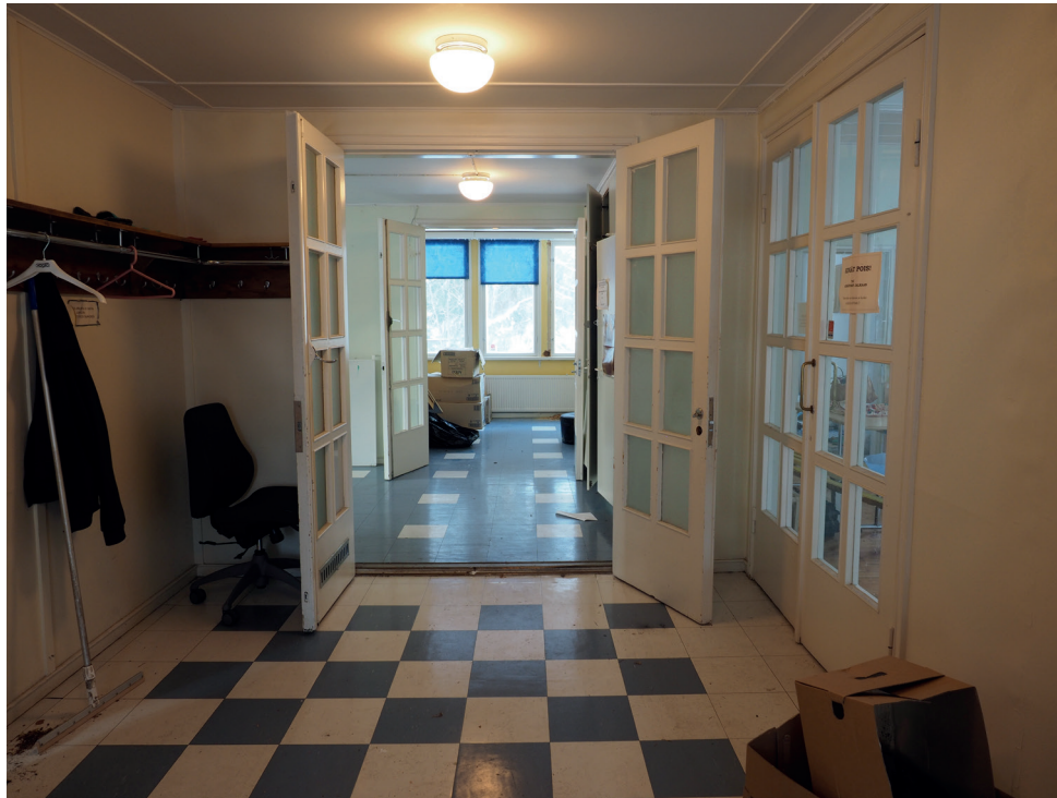
Alkuperäisiä sisäovia ja 1980-luvun lattiamateriaaleja. Kuvassa näkyvät kattovalaisimet ovat todennäköisesti Klaus Michalikin Ornolle suunnittelemaa Bau-sarjaa.
