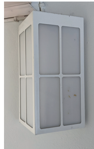
Porrashuoneen, kellarin käytävän ja salin seinävalaisimet ovat Klaus Michalikin Ornolle suunnittelemaa Zenit-sarjaa. Valaisimet ovat vuoden 1985 korjauksen ajalta.
