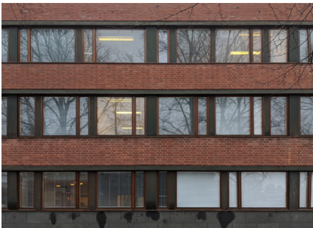
Aalto-yliopiston oppimiskeskus nauhaikkunoita Alvarin aukion suuntaan, Alvar Aalto 1969.
