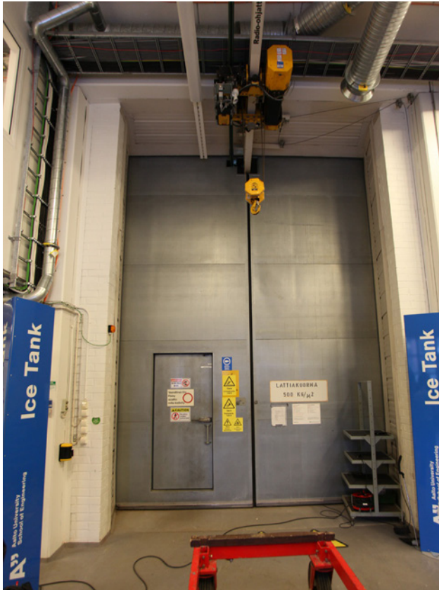
Korkeat metalliovet johtavat mallien varustelutilasta jääkoealtaalle. Katossa näkyy mallien siirtämiseen käytettävä nostin. Lattiapinta on hiottua betonia. Pohjoisseinä on valkoiseksi maalattua tiiltä. Seinä oli ennen laajennusta allas-huoneen ulkoseinä.
