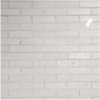
Tiiliseinä valkoiella saumalla.
