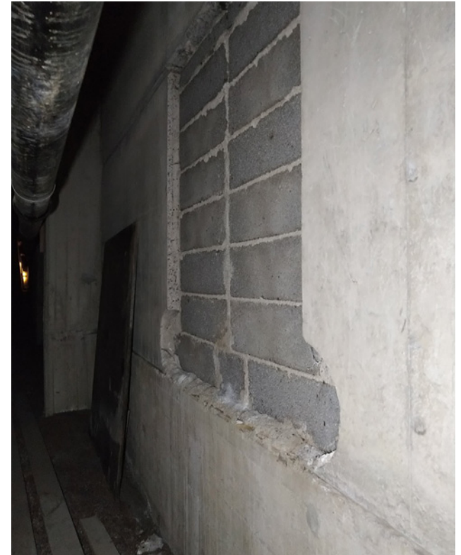
Kuva D - Kevytsoraharkoilla muurattu aukko pohjoisseinustalla
