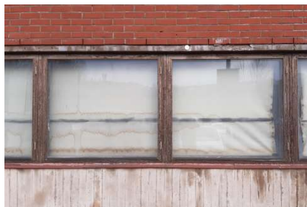
Varaston nauhaikkunat ovat tasajaolliset.
