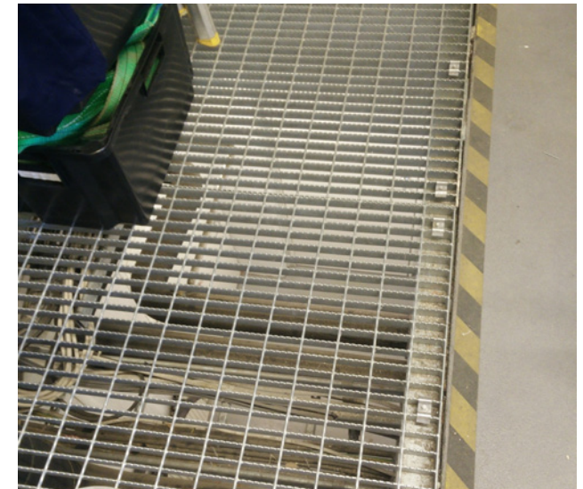
Mallien varustelutilan lattiassa sijaitseva ritilä, jonka läpi näkee kellariin
