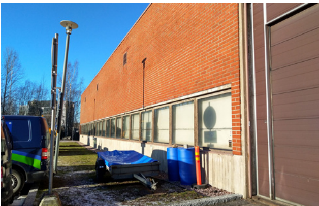
Mallihallin nauhaikkunat ja nosto-ovi eteläisellä julkisivulla.
