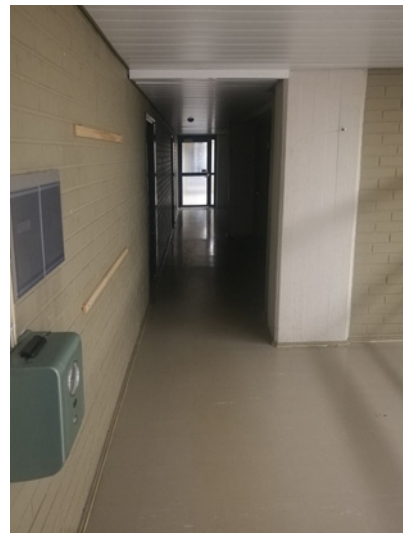
Käytävä kohti Aalto-yliopiston käytössä olevia 1. kerroksen tiloja. Etualalla seinällä kellokorttikone, joka ei enää ole käytössä.
