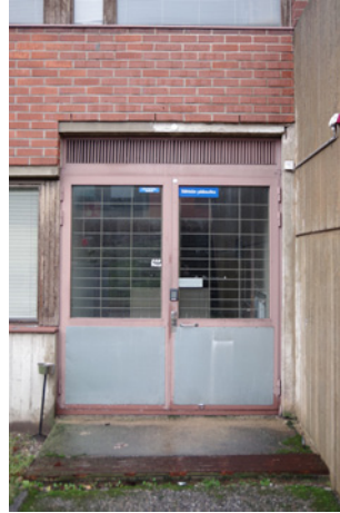
Käyntiovia alkuperäisen osan eteläjulkisivussa
