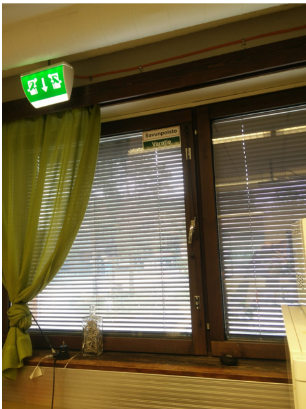
Eteläinen ikkuna toimii hätäpoistumistienä valvomosta ulos. Ikkunalauta ja -karmit ovat puuta, joka on poikkeava materiaali laajennuksen sisätiloissa.
