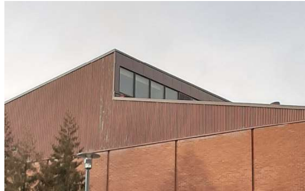
Jääkoehallin yläikkunat ovat tilan eristämisen myötä peitetty.
