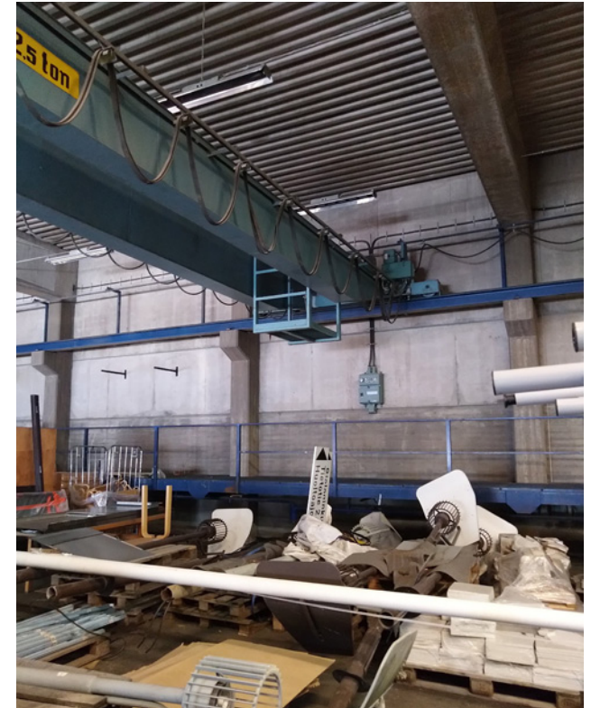
Mallihallin alkuperäistä tekniikkaa ja poimutettu betonikatto.
