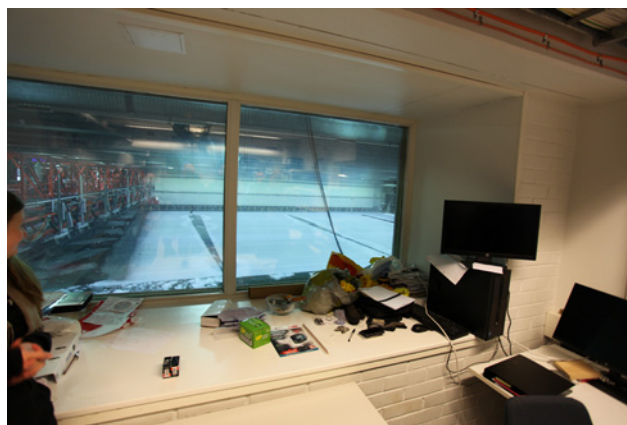
Valvomon pohjoisseinässä on ikkuna jääkoealtaalle. Nykyinen, valvomon ja jääallashuoneen välinen, ikkunaseinä on rakennuksen entinen ulkoseinä. Tämän vuoksi se on huomattavan paksu. Seinän tiilipinta oli ennen osa rakennuksen eteläistä punatiilijulkisivua ja se on laajennuksen myötä maalattu valkoiseksi.
