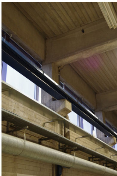
Kantava rakenne ja siltanostimen kisko
