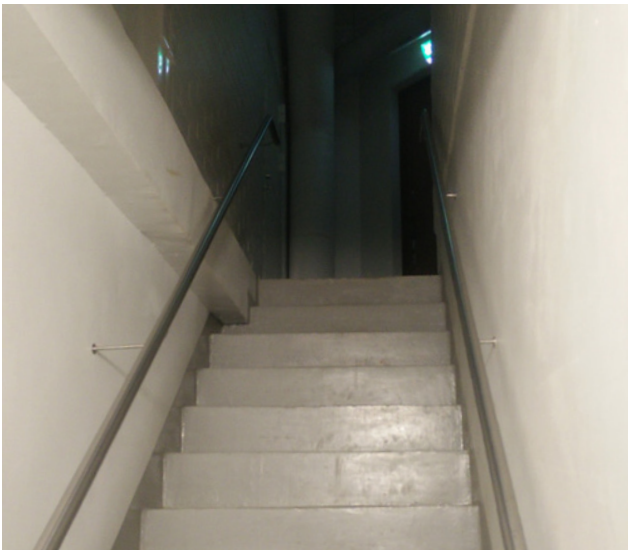
Kellariin johtavat betoniportaavat. Ylhäällä näkyy uloskäynti maantasoon.
