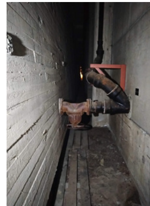
Kuvat E ja F - Putkistoa ja mallikoealtaan tyhjennysputki
