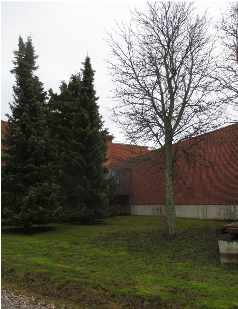
Rakennuksen luoteispuolella sijaitseva vihheralue.
