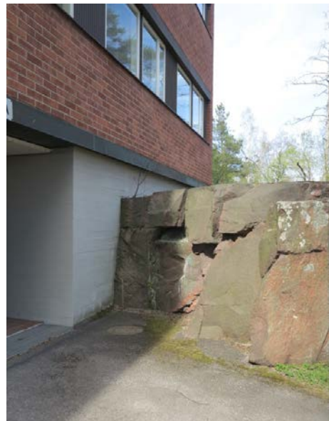
Kalliota on paikoin säilytetty aivan rakennusten seinustoilla.
