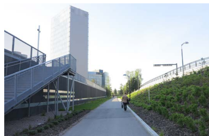
Kevyen liikenteen väylää rajaa tiivisti pysäköintikannen rakenteet ja Hagalundintien pengerrakenteet.
