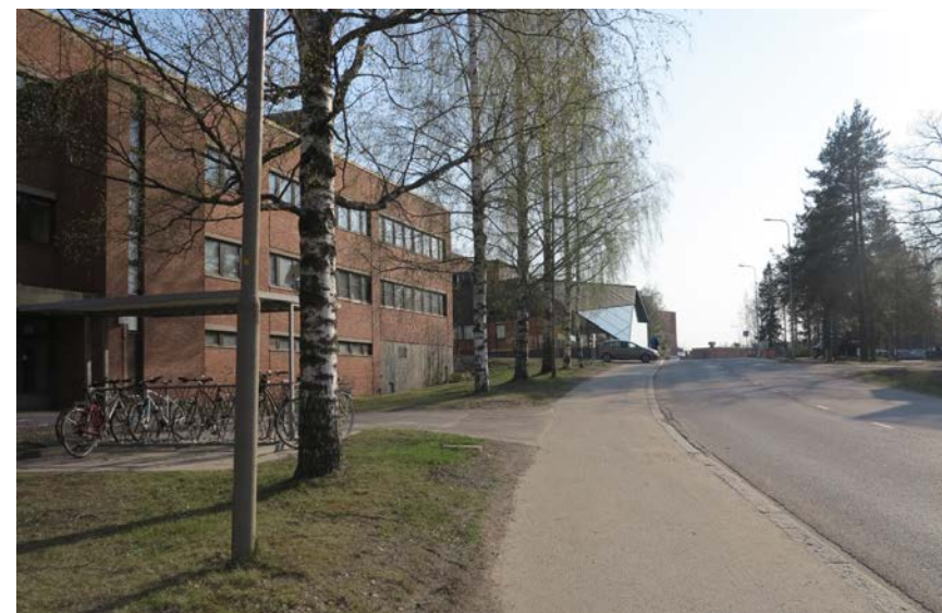
Tietotien varressa taustalla näkyy metroaseman pohjoinen sisäänkäynti.
