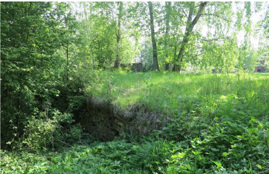
Puutarhan pohjoisreunalla sijainneen kasvihuoneen perustuksia
