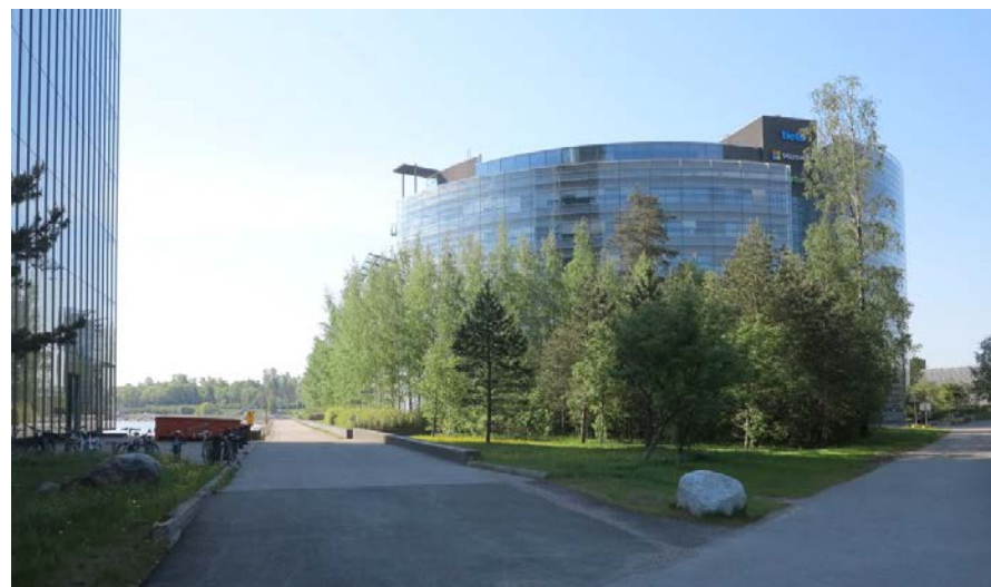
Rakennuksen pohjoispuolella on pieni hyvin tiivis metsikkö.
