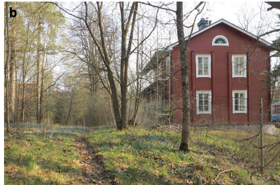
Pihan länsireunan osittain kaksikerroksinen työväenasunto.
