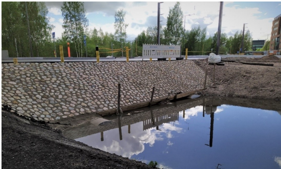
Kuva 54. Maarinniitynojaan laskevat hulevesirummut 21.5.2021.
