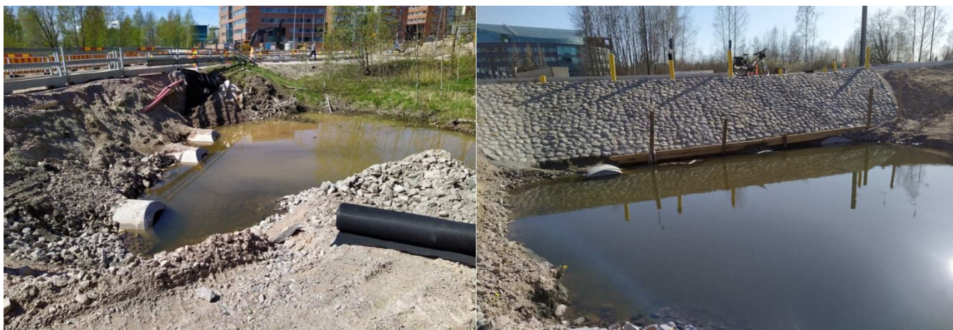
Kuva 3. Laskuojaan purkavat putket. Vasemmalla 10.5.2020 ja oikealla 18.4.2021.
