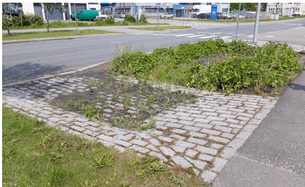
Kuva 58. Vantaan Meiramitiellä toiminnassa oleva biosuodatuspainanne. Etualalla liettasku, johon kiintoaine laskeutuu. Liettasku helpottaa lietteen poistamista rakenteesta.
