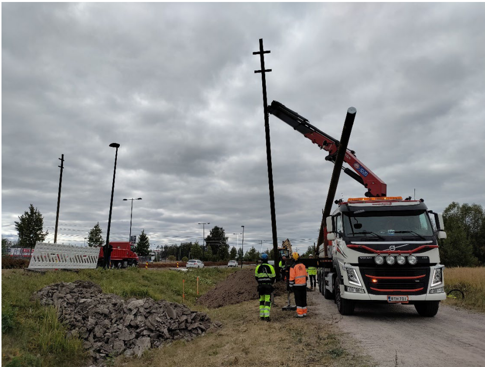
Hyppytolpat pystytettiin Kuitinmäentielle 5.9.2022 urakoitsija Silvertekin toimesta. Kuitinmäentien ympäristössä työt toteutettiin päiväsaikaan, mutta ELY-keskuksen myöntämä lupa työskennellä Länsiväylän tiealueella edellytti, että moottoritiellä työskennellään ainoastaan öisin klo 21–06 välisenä aikana, jotta vilkkaan tien liikenne ei häiriintyisi työmaasta.
