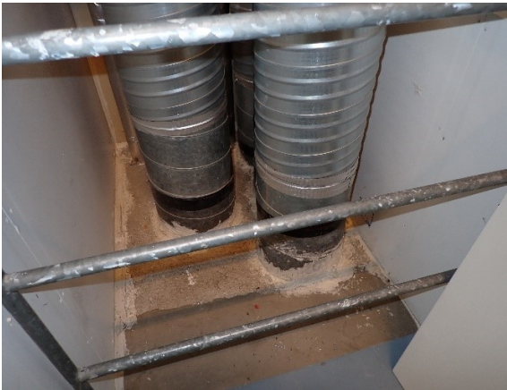
Kuva 5.14 Rakenneosien läpiviennissä on palokatkot kanava-asennuksissa uusittu/korjattu vuonna 2020
