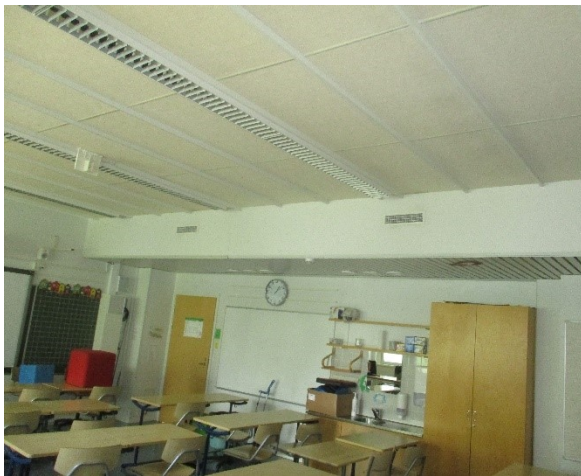
Kuva 5.16 Havainnekuva luokkien ilmanvaihdon säleikkömallisista pääte-laitteiden sijoitteluista
