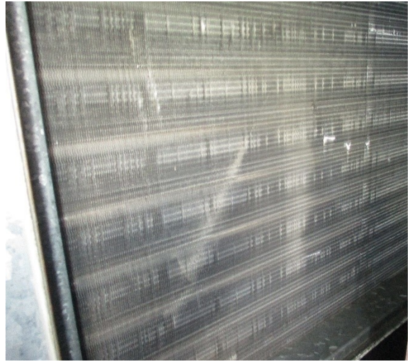
Kuva 5.14 Tuloilmapatteri on pölyinen
