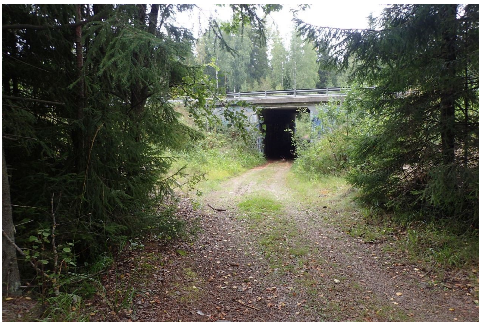
Kuva 21 Turunväylän alikulku on korkea.
