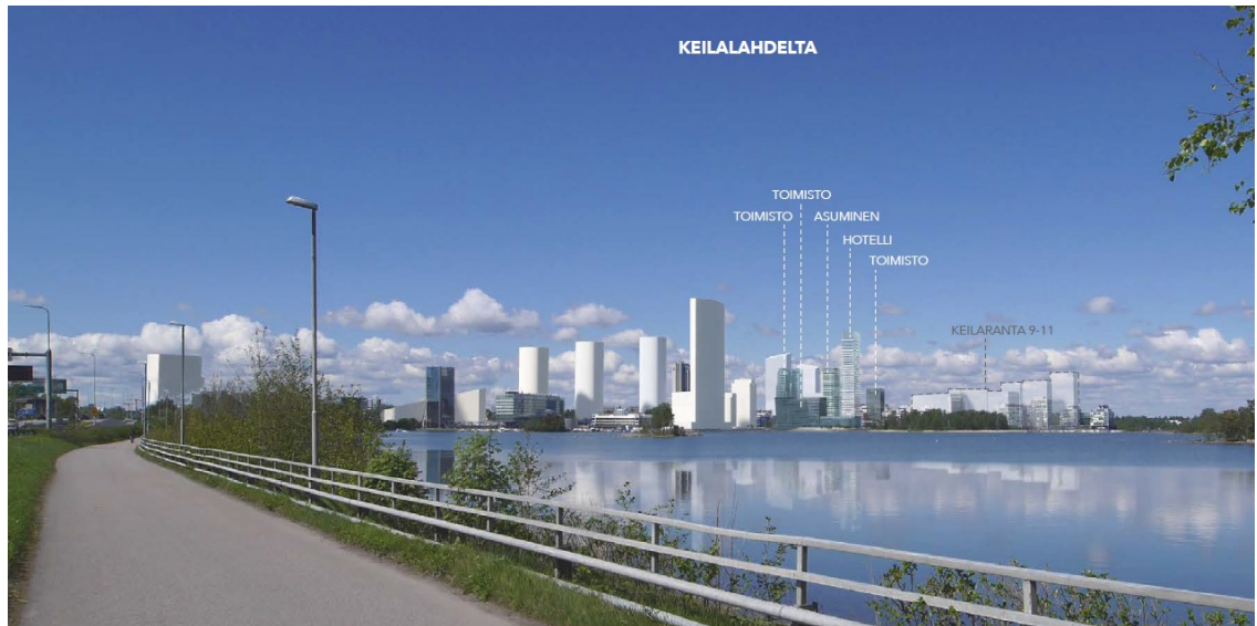
Näkymä Länsiväylältä Keilalahdelle. L Arkkitehdit Oy.
