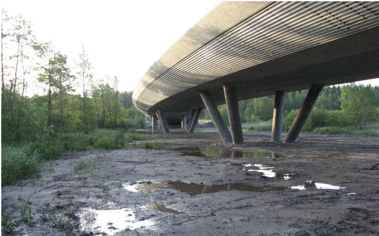
Kuva 9. Finnoonlahden perukan yli rakennettu Matinkylän ja Finnoon yhdistävä silta valmistui loppukesällä 2015. Sillan rakentaminen häiritsi linnustoa keväällä, mutta heti työmaatien purkamisen jälkeen sillan alle ilmestyi pesimään mm. rantasipipari.
