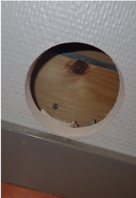
Kuva 3. Rakenneavaus RA5 väliseinärakenteeseen. Rakennusmateriaalit olivat kuivia ja kunnossa.
