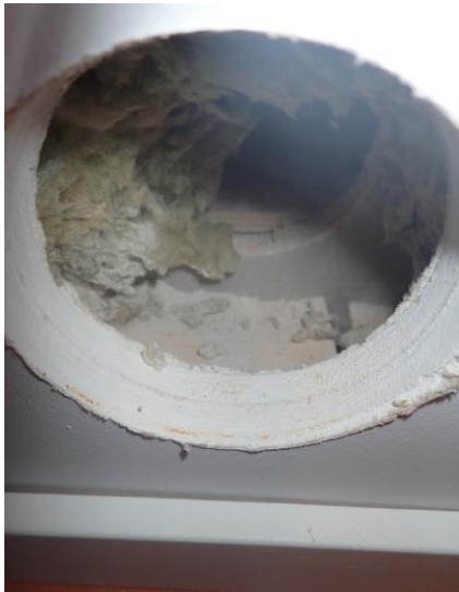
Kuvat 1, 2. Rakenneavaus RA3 väliseinärakenteeseen. Rakennusmateriaalit olivat kuivia ja kunnossa.
