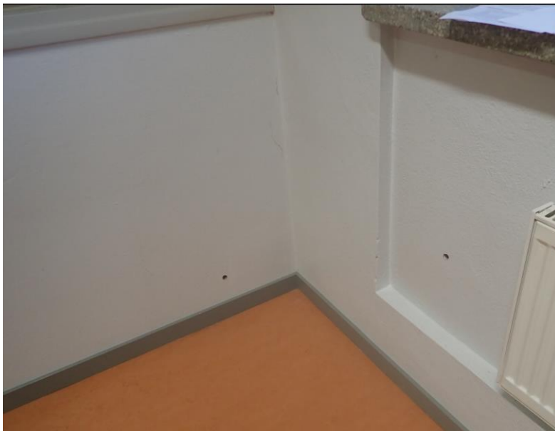
Kuva 6. Tarkastusporaukset RA1 ja RA2 tilassa 2.13. Ulkoseinä- ja väliseinärakenteet olivat kunnossa, eikä näistä havaittu tulevan poikkeavaa hajua sisäilmaan.
