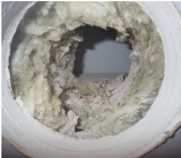
Kuvat 1, 2. Rakenneavaus RA3 väliseinärakenteeseen. Rakennusmateriaalit olivat kuivia ja kunnossa.
