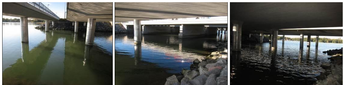
Kuva 38. Valokuvat nykyisistä virtausaukoista (pohjoiseen päin) 2015.
