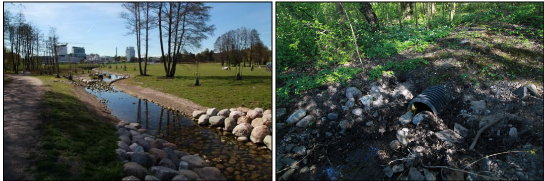
Kuva 36. Otsolahden oja (vasemmalla) ja Otsolahteen laskeva hulevesiviemäri (oikealla), 2017 kesällä.
