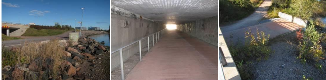
Kuva 39. Valokuvat Otsolahden alikulkukäytävästä (etelästä pohjoiseen).
