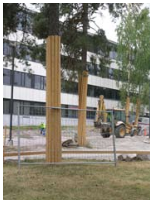
Rakennusaikainen puuston suojaus
