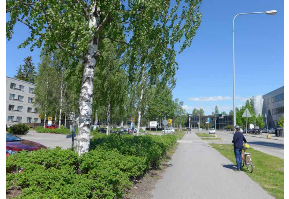
Kuvan vasemmassa laidassa olevan rakennuksen (H13) kaupunkirakenteellinen asemointi herättää kysymyksiä. Asemointi poikkeaa muun alueen noudattamasta koordinaatistosta. Lisäksi rakennuksen sijoittuminen tontin takareunaan tekee katutilasta hahmottoman ja leveän.
