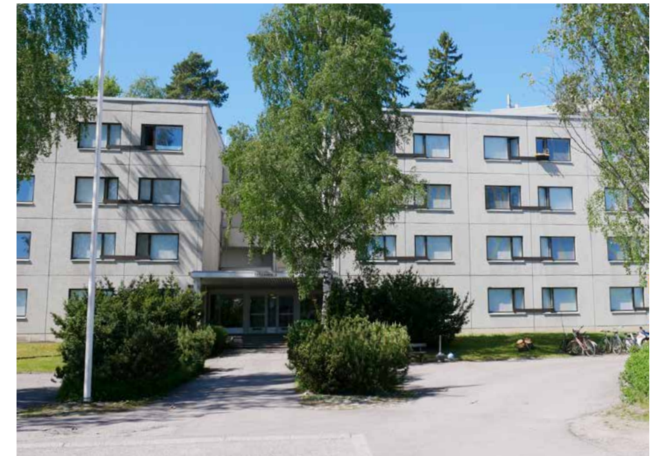
Rakennus on arkkitehtonisilta arvoiltaan ja detajliikaltaan vähäisempi kuin rakennukset Tapiolassa keskimäärin.
