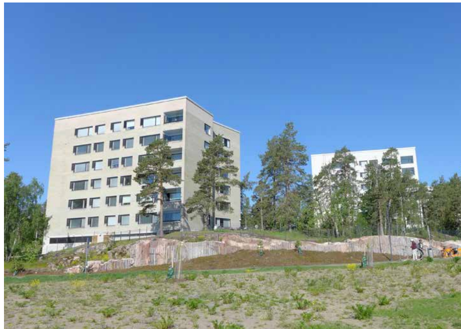
Alueen itäreuna rajautuu tien kattamisen jälkeen lähes samassa tasossa sijaitsevaan puistoon.
