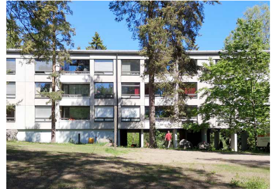
Malmion kokonaisuus ei seuraa Tapiolalle tyypillisesti maastonmuotoja, vaan rakennukset ovat ympäristöstä erillisiä megastruktuureita, laskeutuen rinteeseen suunnitelman sisäistä koordinaatiota noudattaen. Kuvassa rakennustyyppi H01-03.
