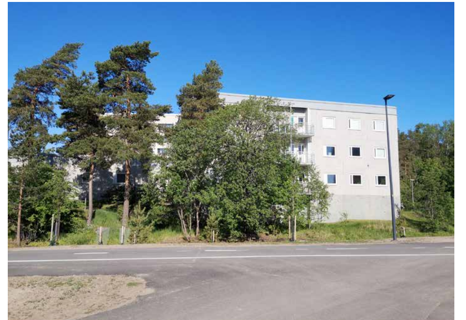
Itäreunan uusi jalankulun ja pyöräilyn väylä hipoo RST-suunnitteluryhmän rakennusta.
