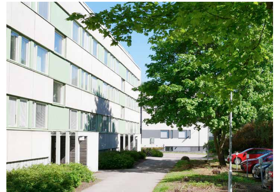
Rakennus I13 (vas) ja uudisrakennus I11.
