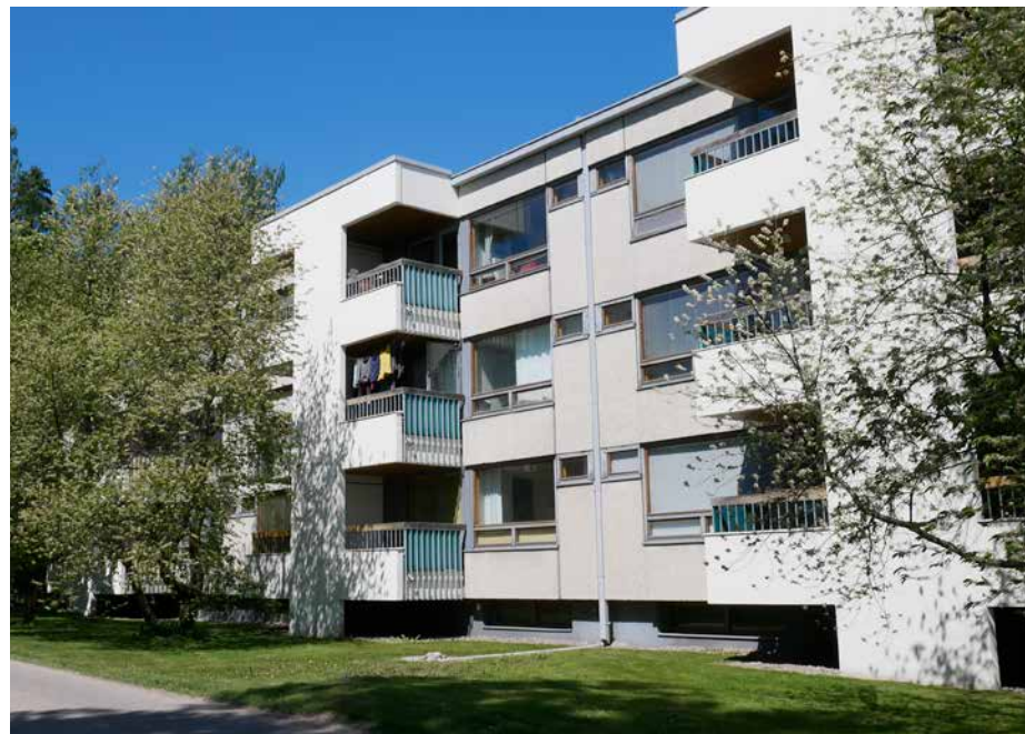
Osa rakennuksista on jo päivitetty uusilla parvekkeilla. Kuvassa rakennustyyppi H04-06.
