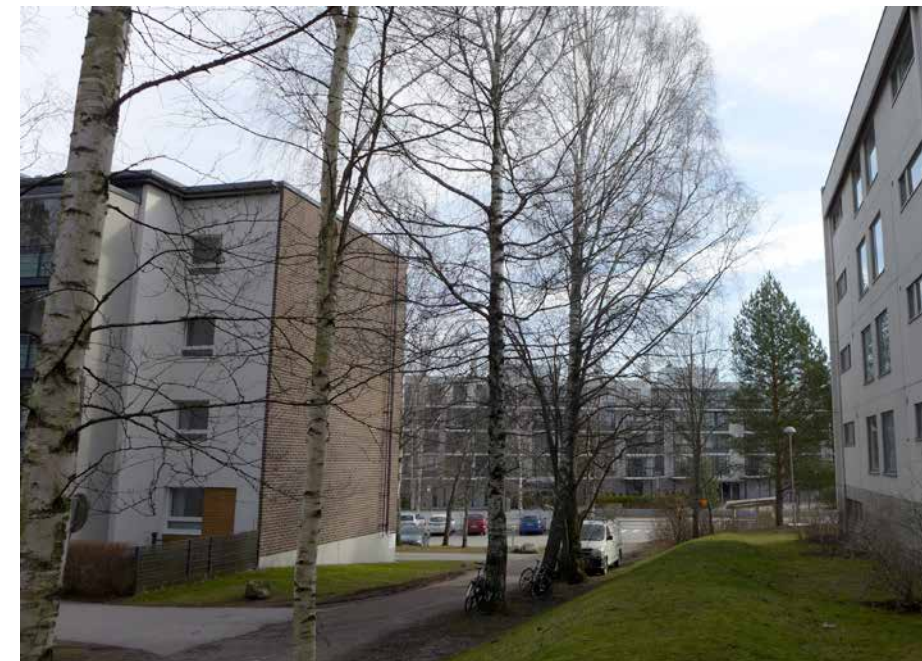
Rakennuksen H17 (oik.) takapuoli muodostaa kolmannen reunan Hyvärisen rakennusten muodostamalle pihapiirille. Pihapiirin keskenäiset korkeudet tulee harkita kokonaisuutena, mikäli korotuksia harkitaan.
