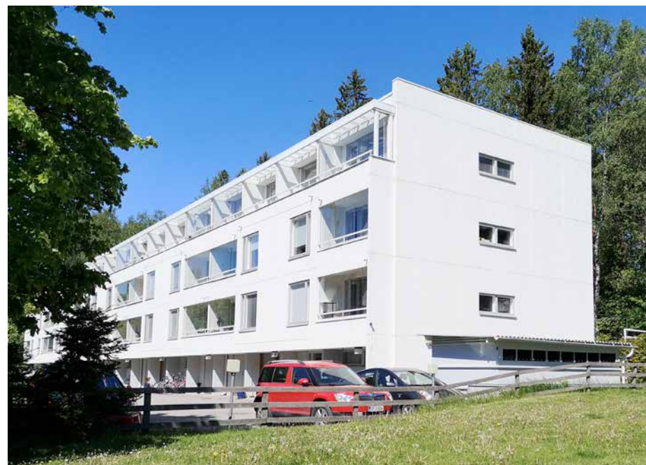
H16 on kahden rakennuksen sarjassa kerroksen matalampi. Ylimmän kerroksen parvekkeisiin on jälkiasennettu kevyt lasitusrakenne.
