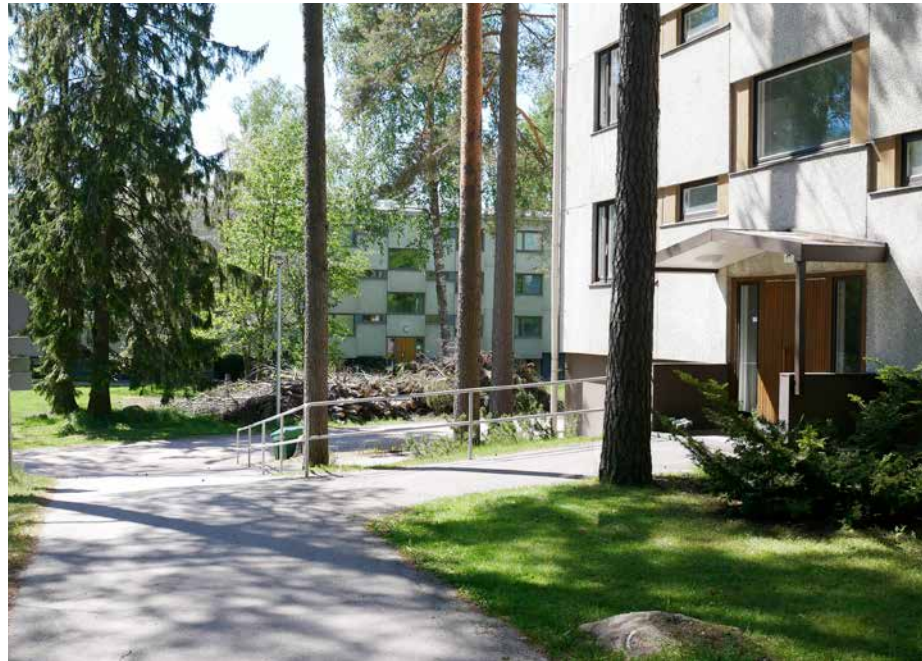
Osaan rakennuksista on uusittu sisäänkäyntikatokset. Kuvassa rakennustyyppi H03.
