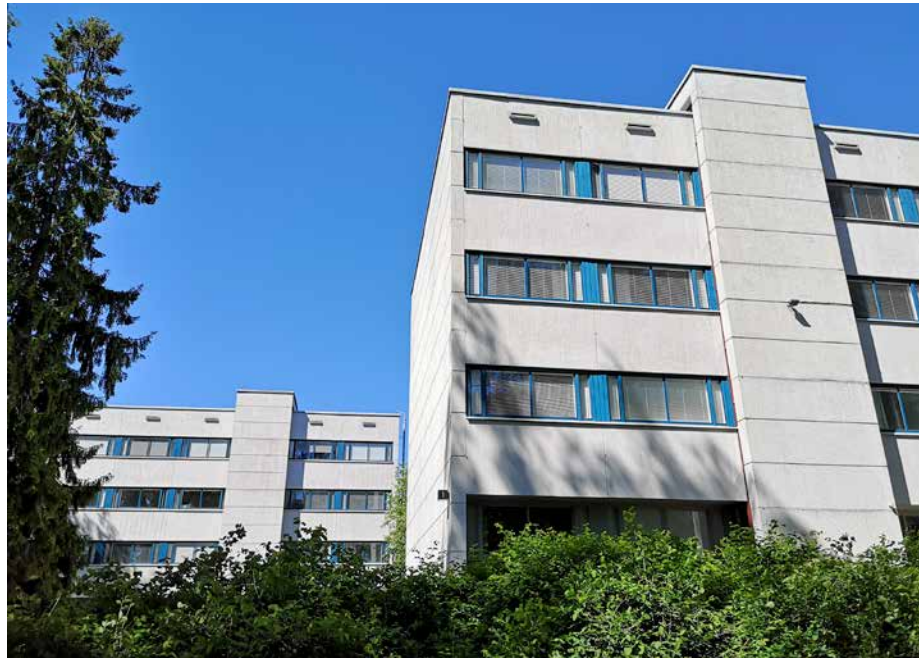
Kuvassa rakennustyyppi H07-11. Porraskäytävän käsittely ”käärii” rakennuskokonaisuuden valmiiksi. Korottamisessa menetettäisiin väijäämättä arkkitehtuurin yksilöllisiä arvoja.
