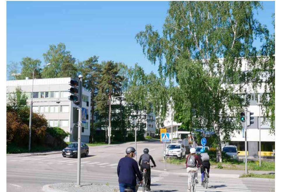
Täydennysrakennuksen I11 (oik.) syvämpi massa, sekä sijoittuminen lähemmän kadunreunaa saa sen vaikuttamaan muita rakennuksia korkeammalta.
