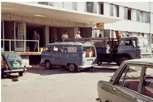
Tapiolan Sähkölaitos Oy:n muutto Teollisuustalosta uusiin toimintoihin Ahertajankujalle 1973. Kuva lastauslaiturilta /-tilasta C-portaan kohdalla. Lähde: Asuntosäätiö, Espoon kaupunginmuseo Kuvaaja: tuntematon
