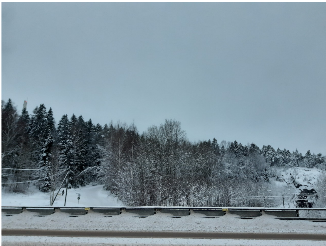
Näkymä suunnittelualueen pohjoisosasta Espoonväylän junaradan ylittävältä sillalta päin katsottuna. Kuvan keskiosassa näkyy Kamreerintie, joka suunnittelualueella toimii tällä hetkellä vain lämpökeskuksen huoltotienä. Kuvan oikeassa reunassa näkyy kallion läpi louhittu ratatunneli, jonka ylitse kulkee maakunnallisesti tärkeä ekologinen yhteys.
