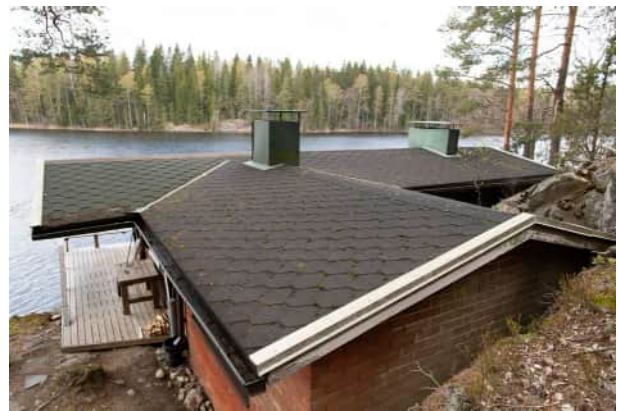
Huopakatto ja savupiippujen uudet pellitykset.
