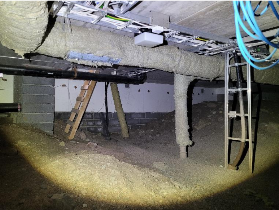
Kuva 4.12. Yleiskuvaa alustatilasta ja puiset tikkaat Lämmönjakohuoneen lattian kulkuluukusta.
