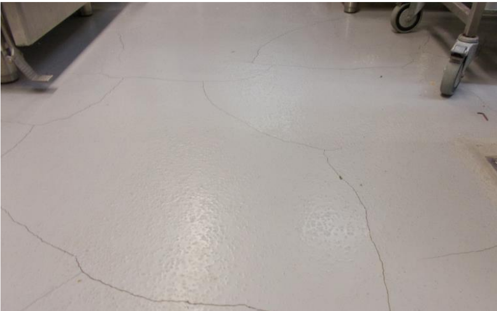
Kuva 4.4. Keittiön A148 lattiaa.
