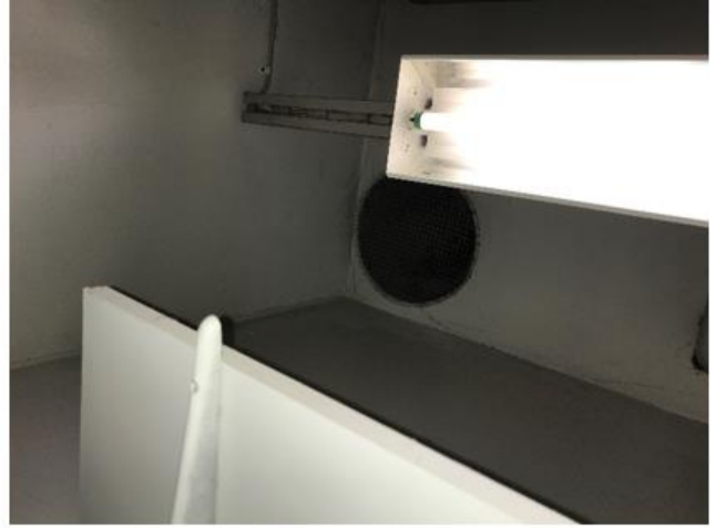
Kuva 5.5. Lämmönjakohuoneen A131 tulo- ja poistoilmanvaihto.
