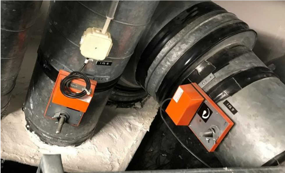
Kuva 6.1. Rikkinäisiä vyöhykepeltejä.
