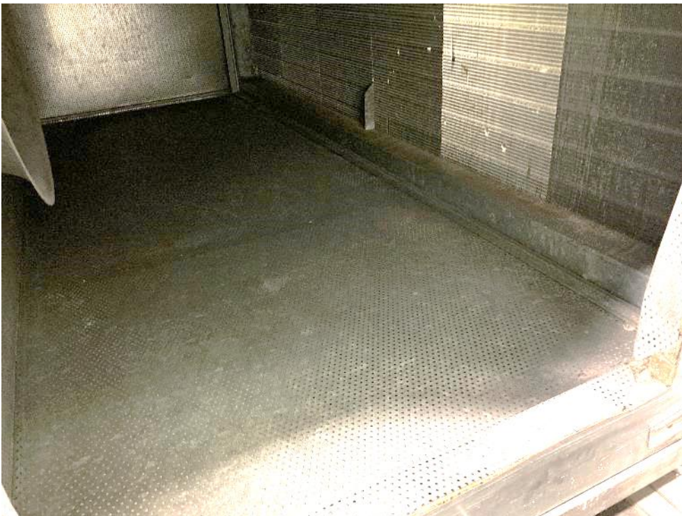
Kuva 5.2. Ilmanvaihtokammion reikäpeltirakennetta.
