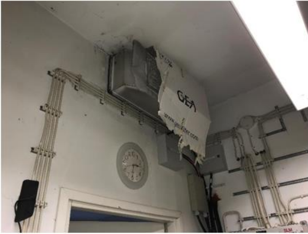
Kuva 5.5. Lämmönjakohuoneen A131 tulo- ja poistoilmanvaihto.
