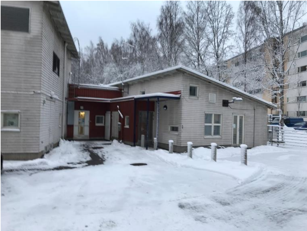
Kuva 5.3. Ilmanvaihtokonehuoneen A2102 raitisilmanottosäleikkö Keittiön sisäänkäynnin ja Parkkipaikan vieressä. Kuvan oikeassa reunassa on Kirjasto / vanha asunto.
