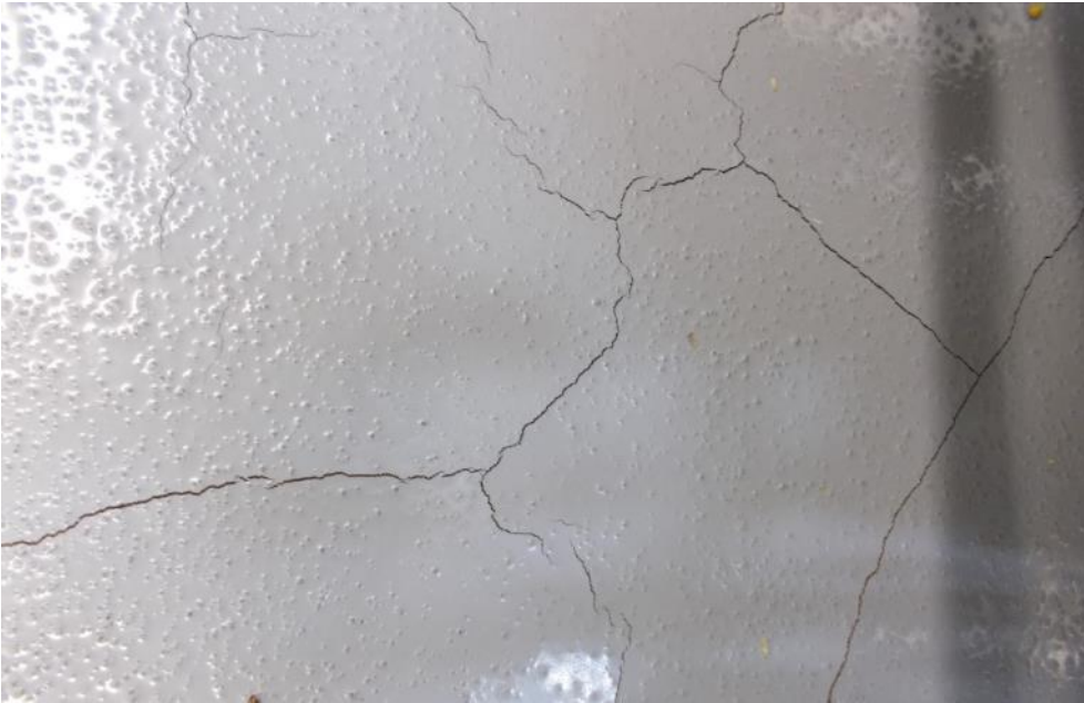
Kuva 4.5. Keittiön A148 lattiaa.
