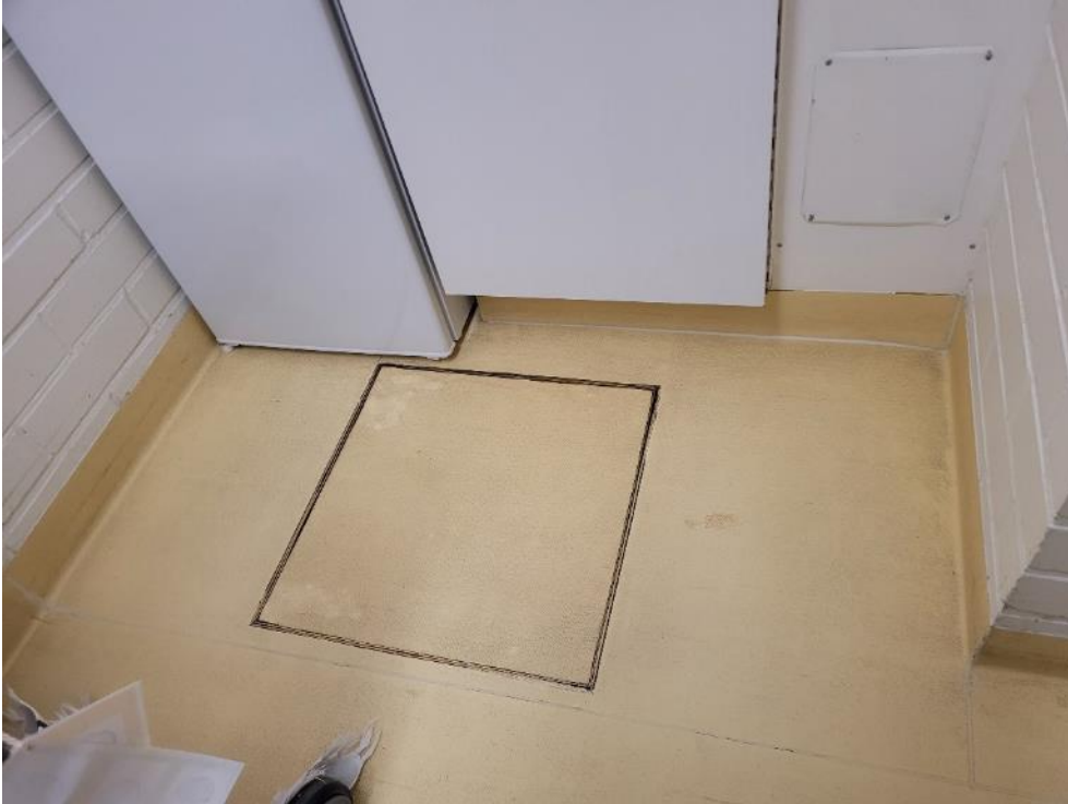
Kuva 4.1. 3081 Lakelan päiväkoti / 1.kerroksen Varaston 127 lattialuukku.
