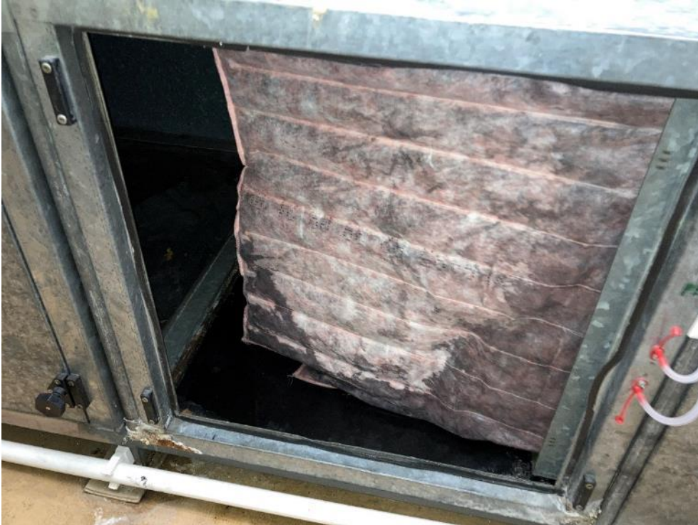
Kuva 5.1. 3081 Lakelan päiväkoti / Tuloilmansuodattimille pääsee lumi, joka sulaa vedeksi.
