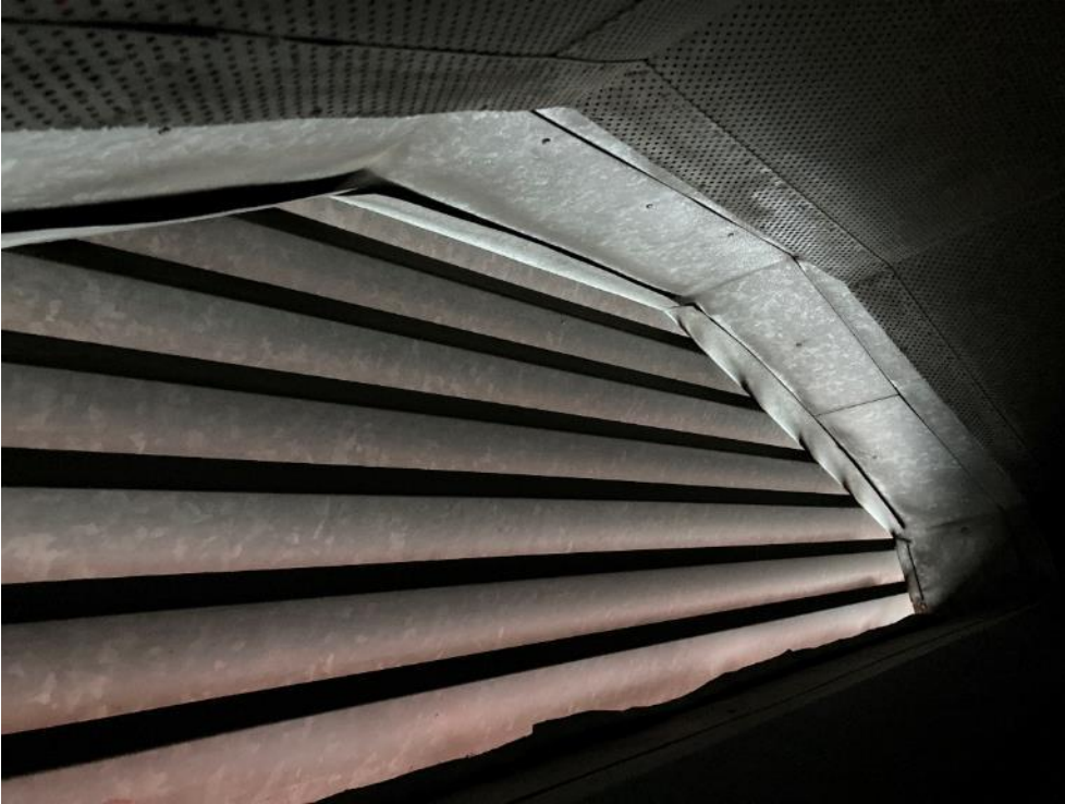
Kuva 5.3. 3081 Lakelan päiväkoti / Ilmanvaihtokoneen raitisilmasäleikön yleiskuva sisäpuolelta.
