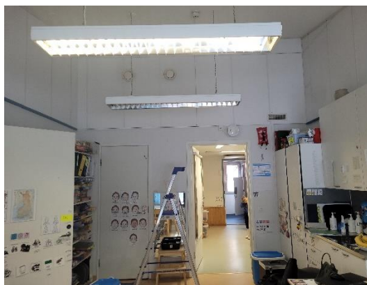
Kuva 1. Leikkihuoneessa 102 ei havaittu poikkeavia hajuja tai viitteitä vaurioista. Poistoilmaventtiilit ja tuloilmaventtiili sijaitsivat ylhäällä samalla seinällä. Ilmamäärät mitattiin ko. tilasta.
