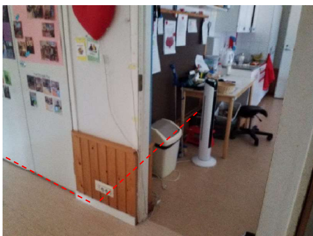
Kuva 15. Tila 155. Merkittävää ilmavuotoa alapohjasta.
