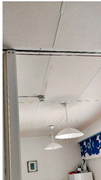
Kuva 36. Tilojen 135 ja 136 katossa on vanhoja akustiikkalevyjä, joista voi irrota teollisia mineraalikuituja.
