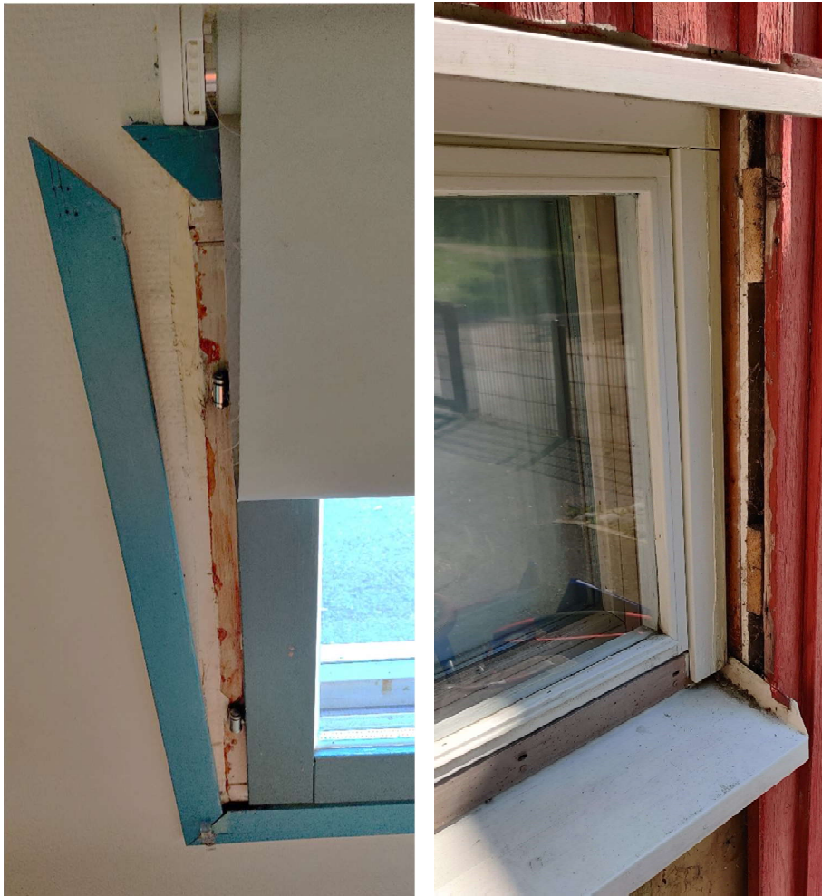
Kuva 24. Ikkunat ovat MSE-puuikkunoita. Ikkunoiden tilkevälit ovat uretaania ja ne on tiivistetty sisäpuolelta massalla. Ikkunapellitysten kaadot ovat riittäviä.
