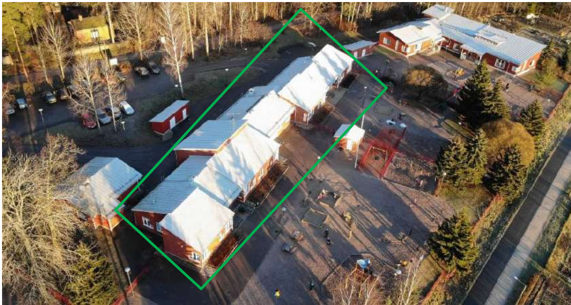
Kuva 2. Tutkittava rakennus ulkoapäin (kuva: ESPOON KAUPUNKI, Tilapalvelut-liikelaitos, Kunnossapitopalvelut, Tarkastusryhmä 26.1.2022)
