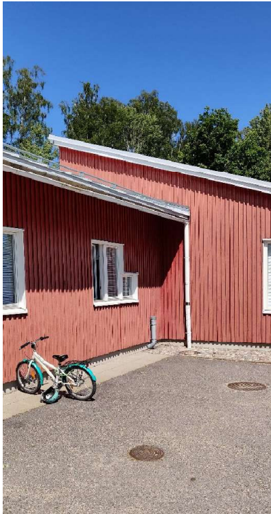
Kuva 4. Rakennuksen vierusta on pääosin asvaltoitu, sisäpihan puolella vierustalla on osittain laatoitusta/kivetystä. Sadevedet on johdettu suoraan sadevesiviemäriin
