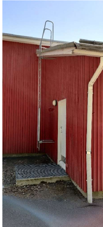
Kuva 4. Rakennuksen vierusta on pääosin asvaltoitu, sisäpihan puolella vierustalla on osittain laatoitusta/kivetystä. Sadevedet on johdettu suoraan sadevesiviemäriin
