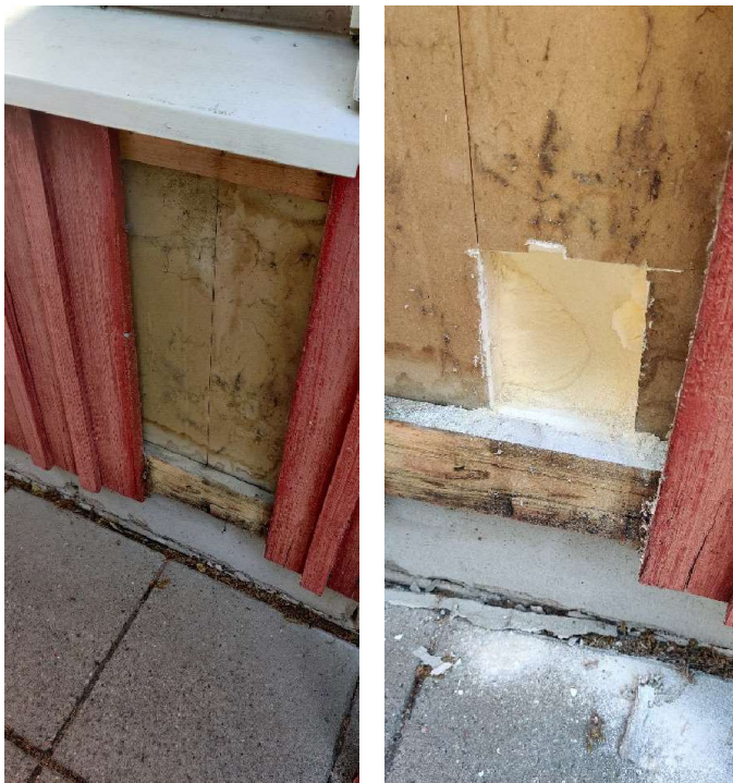
Kuva 23. Ulkoseinän rakenneavaus ulkopuolelta. Rakenne on suunnitelman mukainen. Ulkoverhouksen takana on tuuletusrako. Tuulensuoja levy on liimattu polyuretaanieristeeseen.
