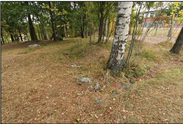
AKDG7193:48. Sepänkylä/Smedsby. Stens. Rakennuksen kiviperustusta. Kuvattu lännestä. Kuvaaja Tuija Väisänen.
