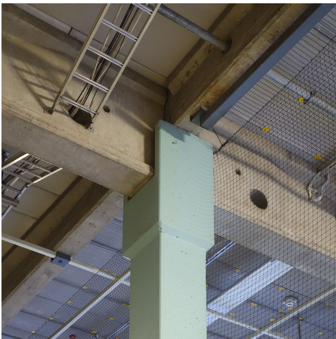
Kuva 3. Keran itäisen hallin pilarin, palkkien sekä kevytbetonilaatan liitos.
