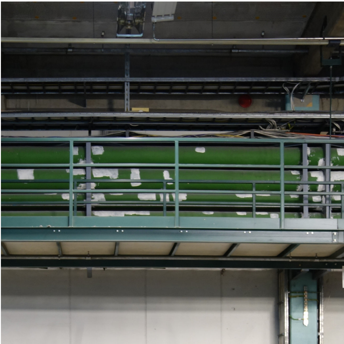
Kuva 4. Keran itäisen hallin modulaarinen metallinen kulkusiltarakenne.
