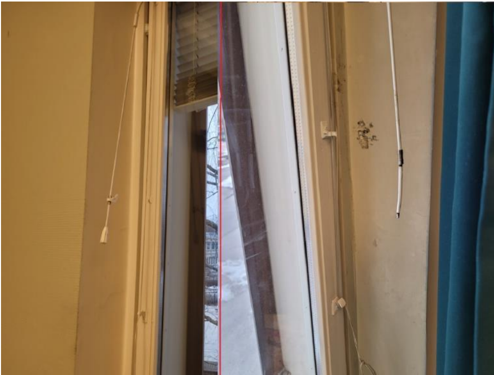
Kuva 4.11. Kaikki sälekaidinsäätimet tai vähintäänkin kiinnike on rikki.
