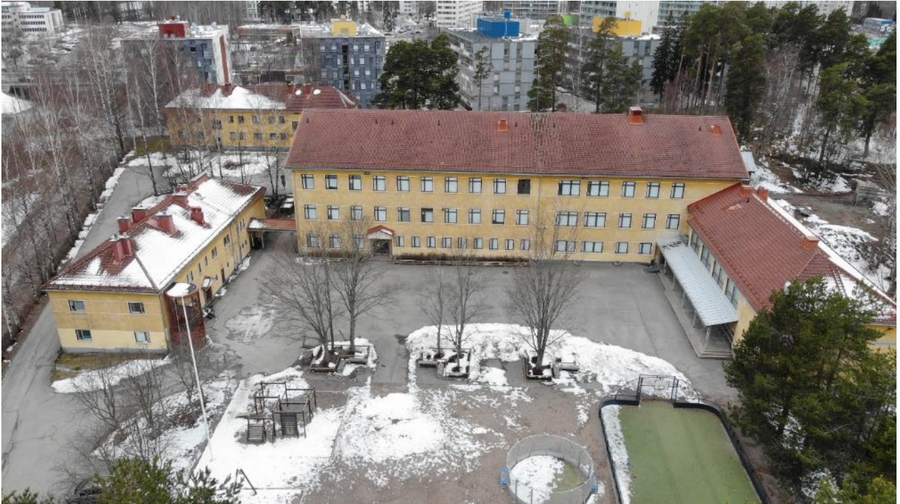
Ilmavalokuva kohteesta 5.4.2023. D-osan rakennus kuvan vasemmassa reunassa.
