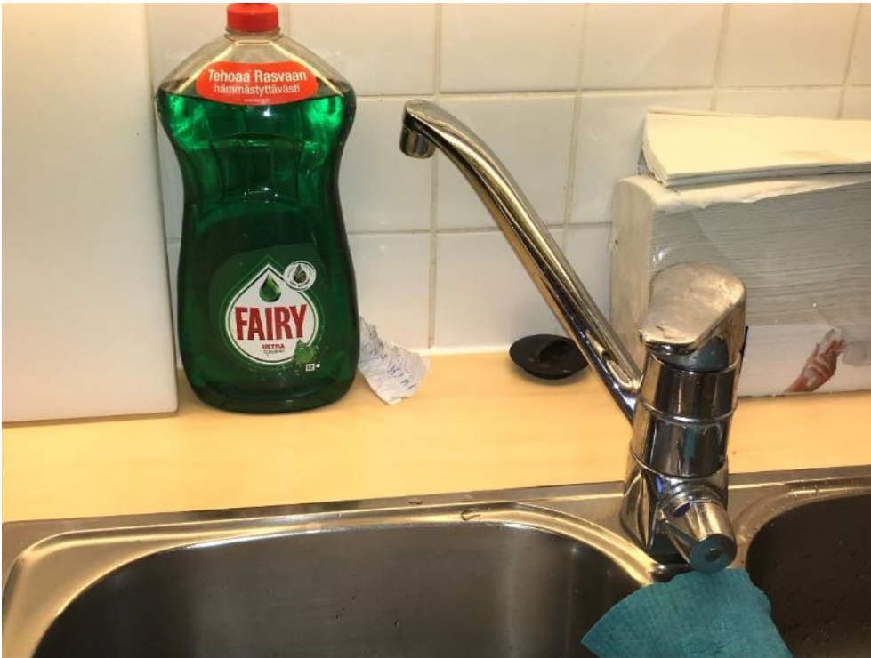
Kuva 5.7. Useista allashanoista puuttuu tai niissä on väärät sivuliikerajoittimet ja vesi pääsee pöydille ja tasojen taakse.
