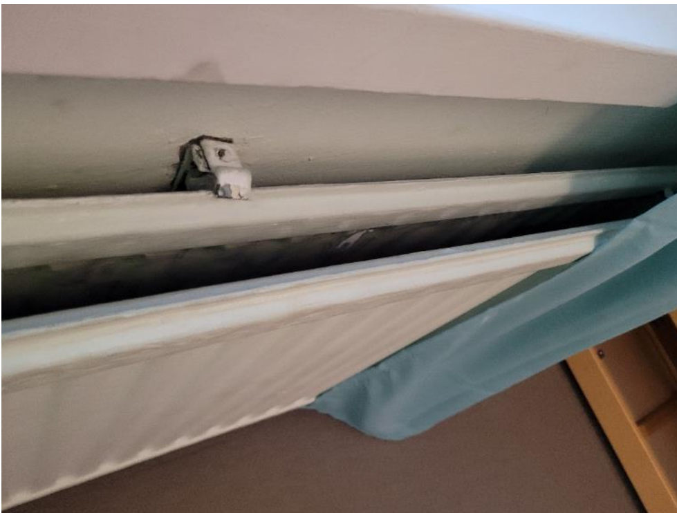
Kuva 4.1. Tilassa 211 patterikannake on lähes irti.
