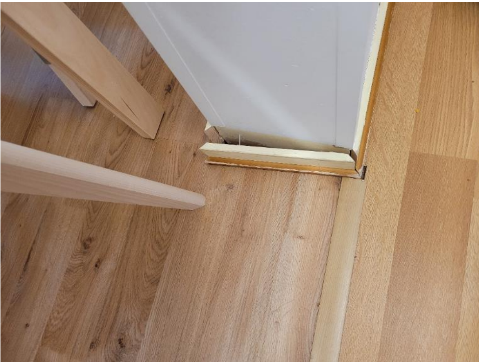
Kuva 4.21. Tilassa 119 jalkalistapala on irti.
