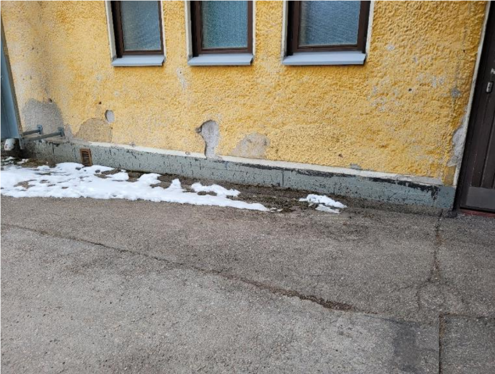
Kuva 4.30. Rappausvaurioita ulkoseinällä.
