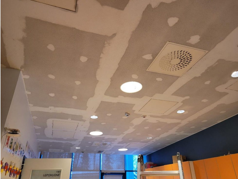
Kuva 4.1. Alakattojen käsittely jäänyt kesken - kuvassa tilan 145 alakattoa.
