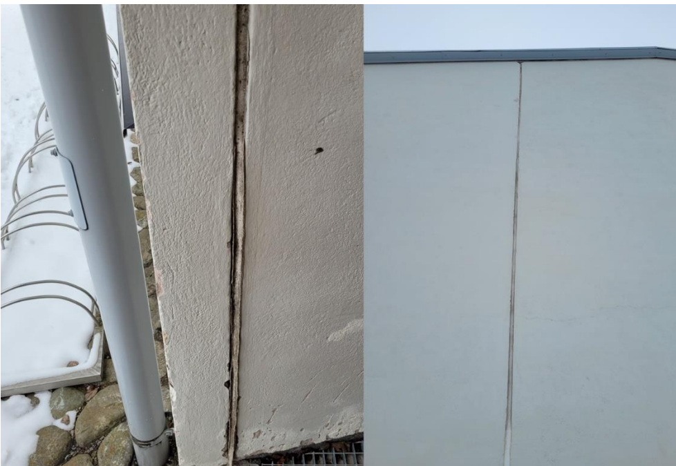
Kuva 4.8. Huonokuntoisia elementtisaumoja.
