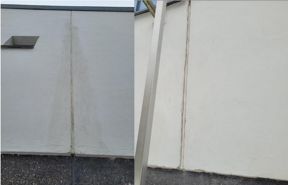
Kuva 4.9. Huonokuntoisia elementtisaumoja.
