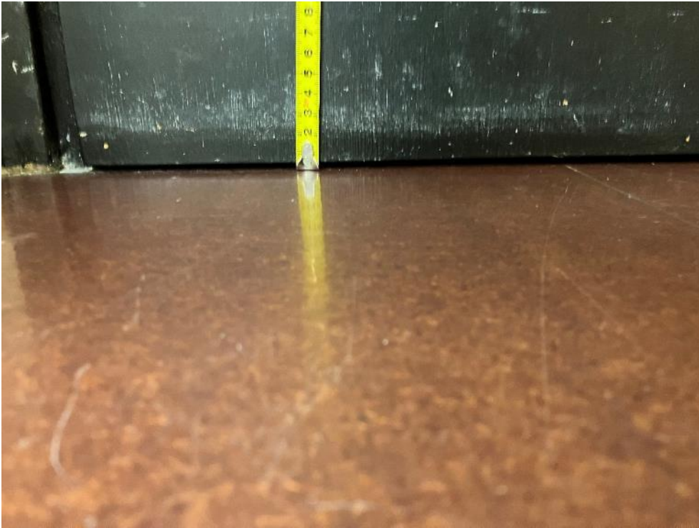
Kuva 4.17. Tilassa 226 ovirako on noin 5 millimetriä korkea.
