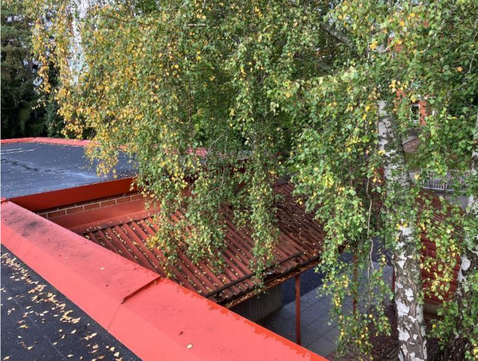
Kuva 4.33. Koivun oksat osuvat kattoon.
