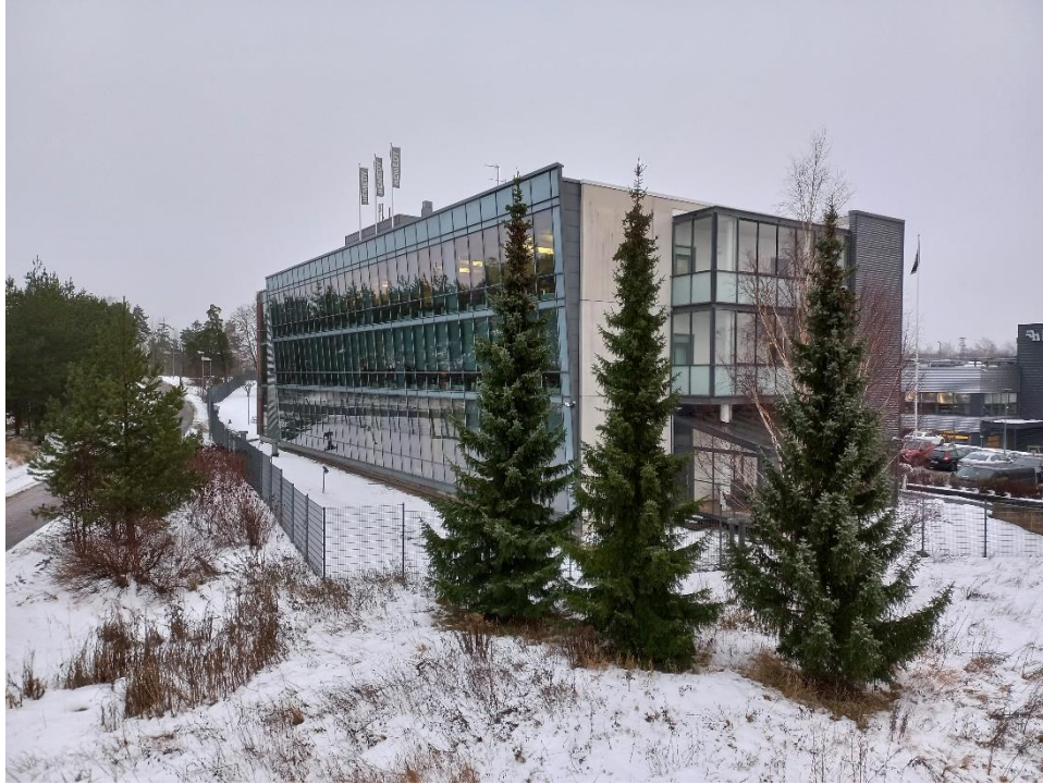
Kuva: Rakennus kuvattuna lounaasta koilliseen joulukuussa 2023.
