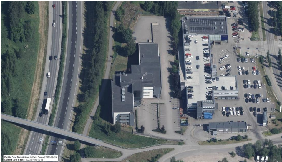
Kuva: Viistokuva rakennuksesta ja tontista etelästä kuvattuna (Mapspace).
