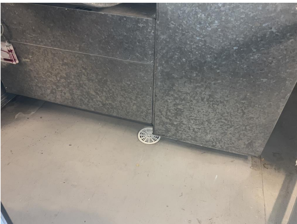
Kuva 5.1. Raitisilmakammio on viemäroimättä.
