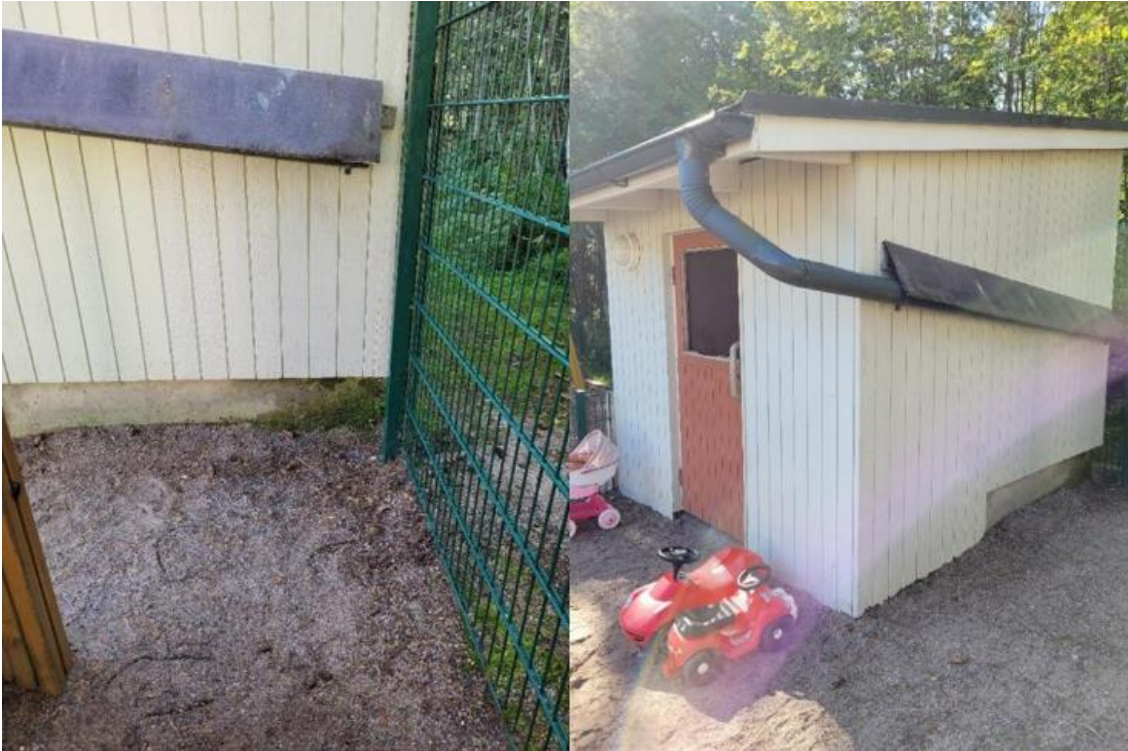
Kuva 4.21. Ulkovarastojen sadevedenpoistojen johtaminen puutteellinen. Ulkoverhouslaudoitus alle 30 cm maanpinnasta. Sokkelin jatkuva kosteusrasitus rapauttaa betonia ja altistaa liittyvät puuosat kosteudelle. Sokkelista ei havaittu patolevyä.
