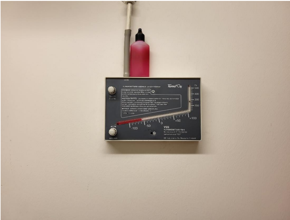
Kuva 4.30. Tila 145 painemittarin neste vajaa.
