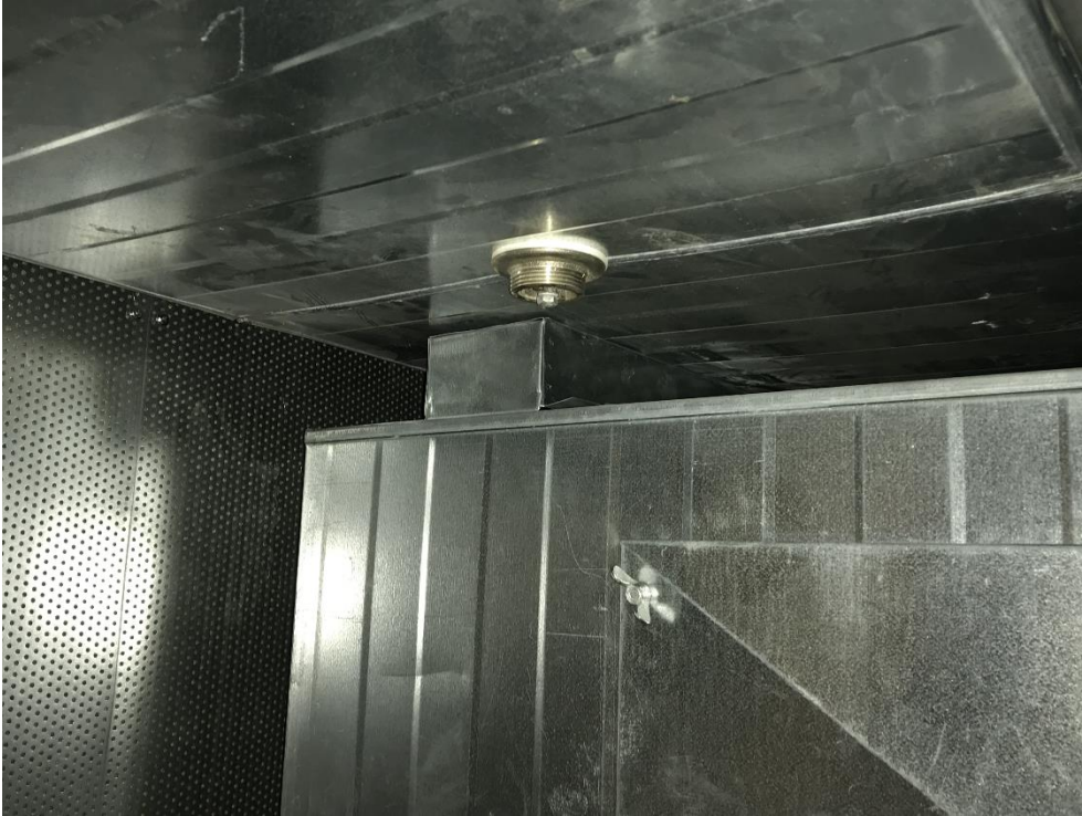
Kuva 5.1. Raitisilmakammio on viemäroimättä, viemärintiä on asennettu.
