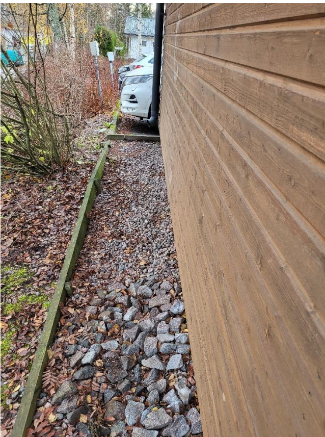
Kuva 4.3. Roskakatoksen sadeveden johtaminen kauemmas.
