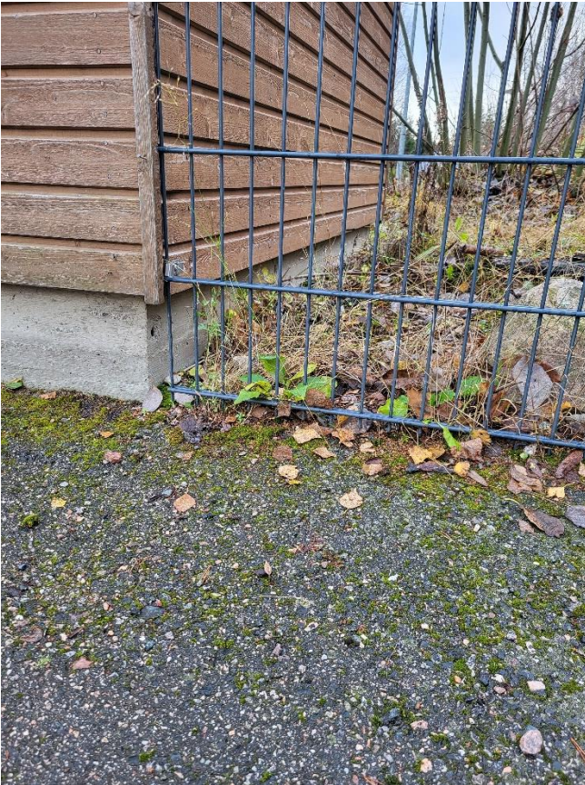
Kuva 4.32. Tila 146 maanpinta alle 30 cm julkisivulaudoituksesta.
