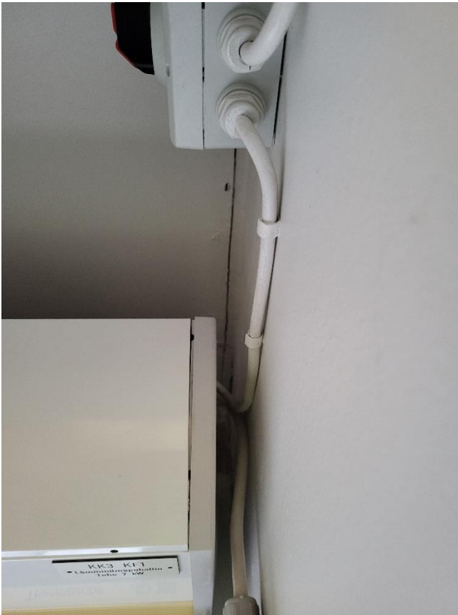
Kuva 4.18. Tila 132 halkeama katonrajassa.
