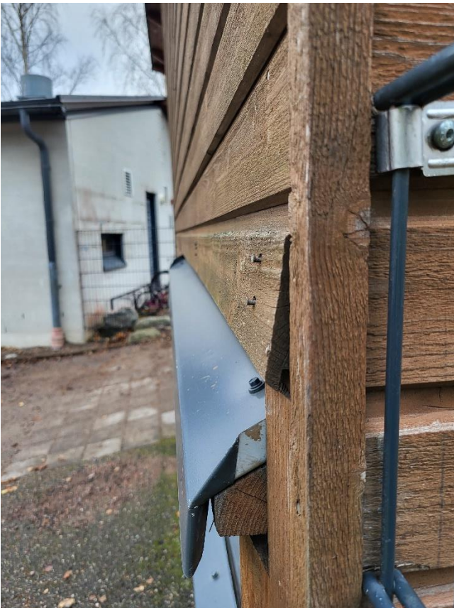
Kuva 4.33. Tila 146 naulat nousseet laudoituksesta ja huoltomaalaus.
