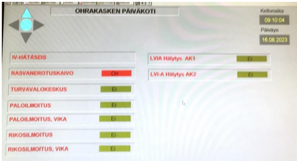
Kuva 6.2. Rasvanerotuskaivon hälytys päällä.
