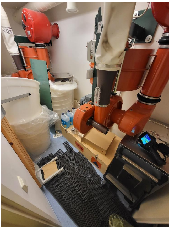
Kuva 4.31. Tila 145 ylimääräistä tavaraa.
