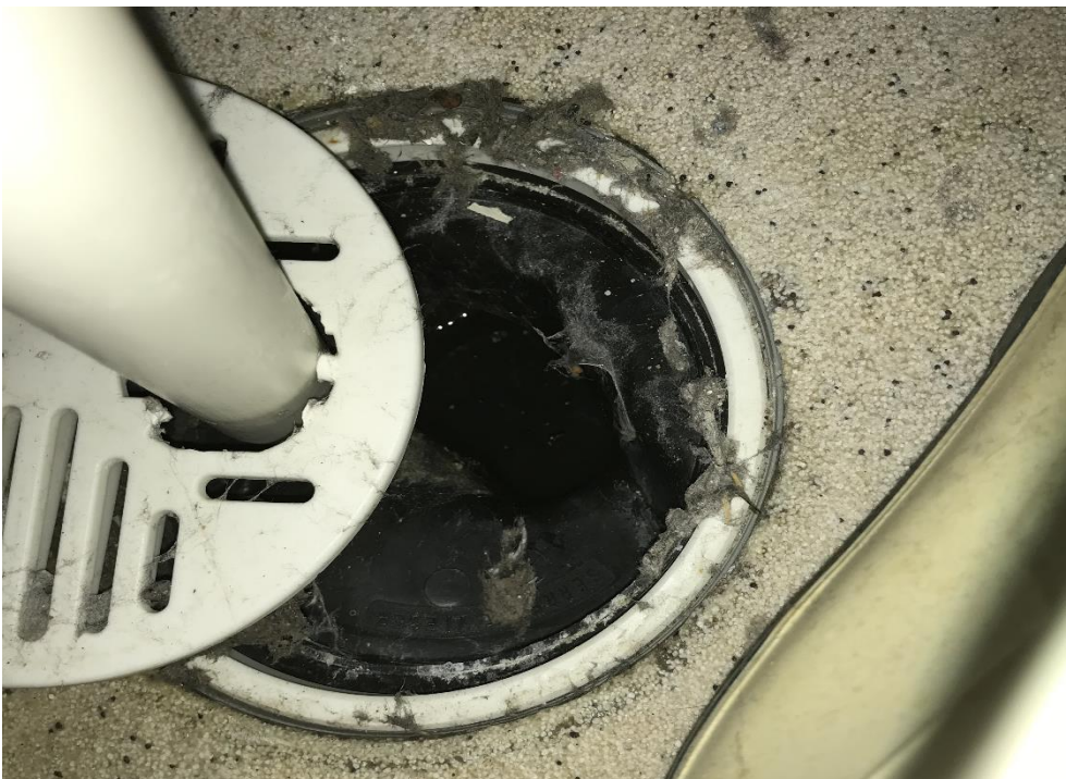
Kuva 5.4. Keittiön siivouskomeron 134A lattiakaivo kuiva.
