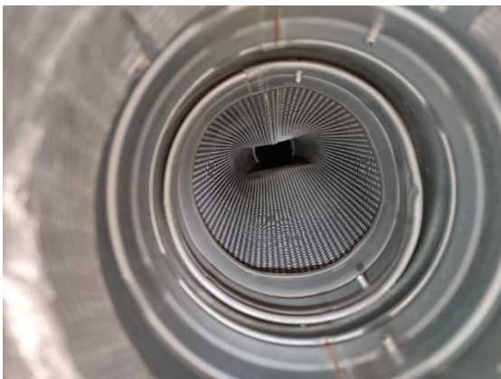
Kuvat 7, 8. Vanhan osan tilan SK1013 tuloilmakanavan äänenvaimentimessa rei'itetty pelti, alla kangas, äänenvaimentimen eristemateriaalista ei tietoa. Kanavasta otettiin näyte TK7, jossa kuituja 4,6 kpl/cm 2 , mikä on tavanomainen määrä.
