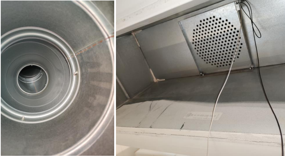
Kuvat 9, 10. Vanhan osan tilan SK1020 tuloilmakanava ja päätelaite puhdas. Mineraalikuitulähteitä ei havaittu.
