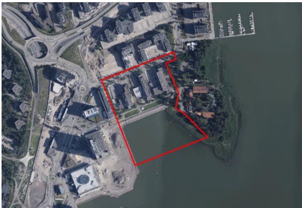
Kuva 1. Suunnittelualueen rajausta noudattaa asemakaavamuutoksen aluerajausta (Ilmakuva: Espoon kaupunki, 2022).
